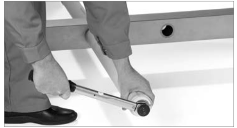
Bild 4: Montage mit Drehmomentschlüssel
