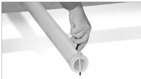
Рис. 3. Монтаж с контропорой.
