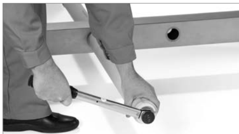
Рис. 4. Монтаж с динамометрическим ключом.
