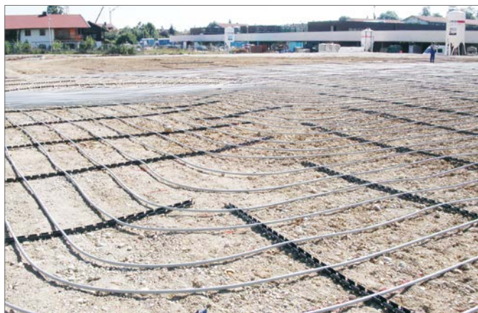
Rys. 5-2 Montaż kolektora
