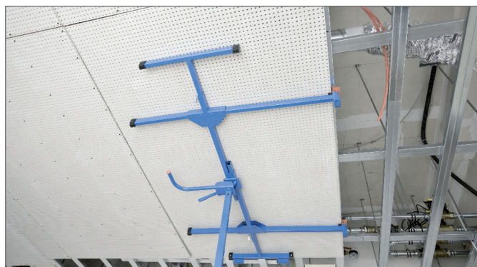
Obr. 4-21 Zvedák desek pro správné polohování stropních desek
