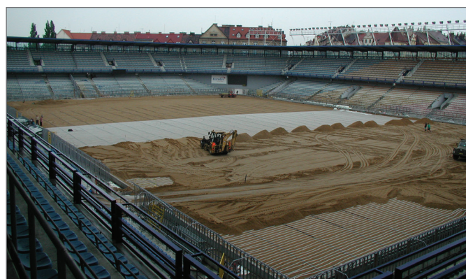
Obr. 16-2 Pokládka a zasypání topných trubek
