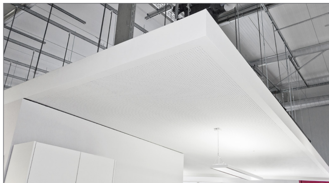
Obr. 4-8 Příklad provedení volně zavěšené stropní desky
