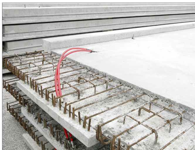
Obr. 11-4 Moduly BKT u poloprefabrikovaných dílů
