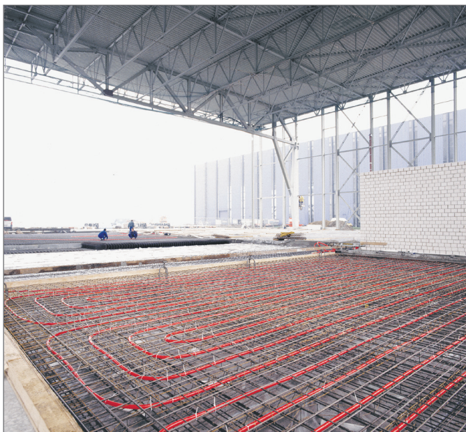
Obr. 12-1 Plošné vytápění v průmyslové hale
