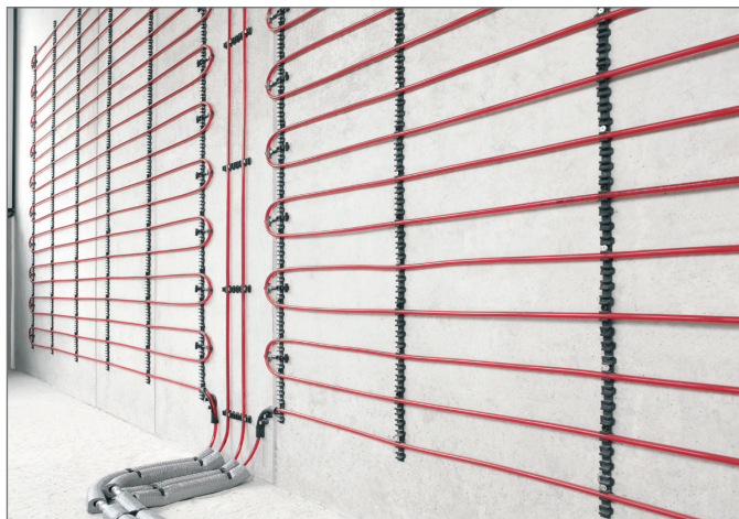
Obr. 7-1 Stěnové vytápění / chlazení - mokrý způsob
