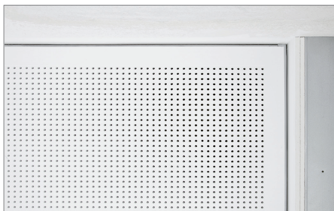
Obr. 4-31 Příklad kluzného napojení na stěnu
