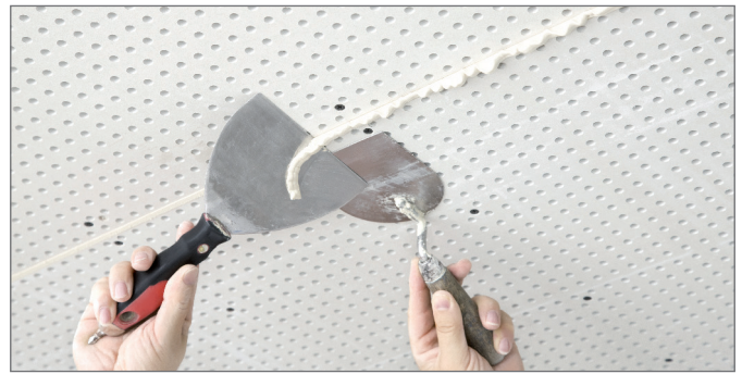
Obr. 4-25 Odstranění vytvrzené tmelící hmoty
