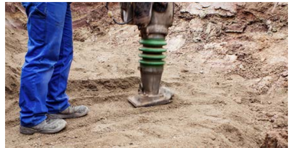
Abb. 05-25 Auflagebereich des Schachtbodens vorbereiten
