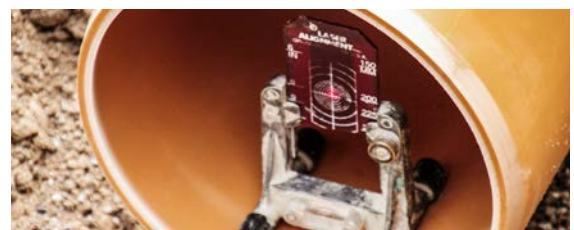
Abb. 05-11 Gefälle-Kontrolle mit einem Laser
