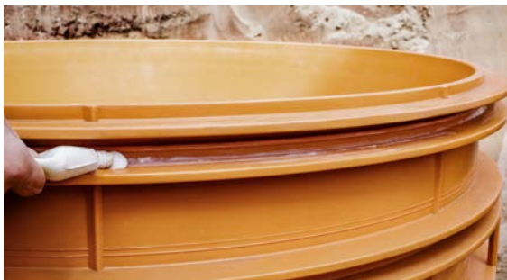
Abb. 05-26 Oberste Dichtkammer mit Gleitmittel einstreichen
