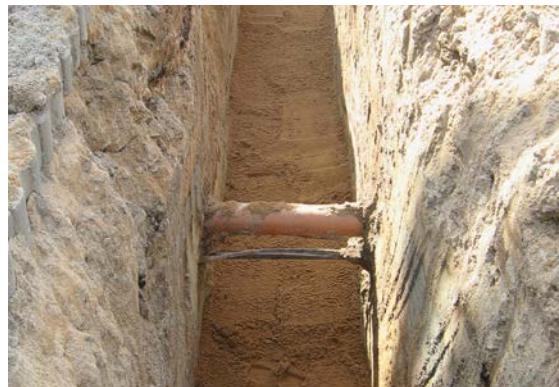
Fig. 07-2 Fond de la tranchée avec un support de tuyaux
