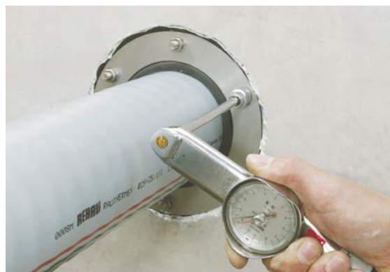
Fig. 05-12 Montage avec clé dynamométrique
