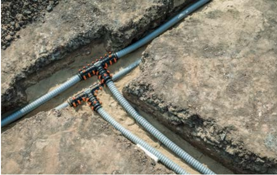
Fig. 07-4 Pose en mode de construction ouverte
