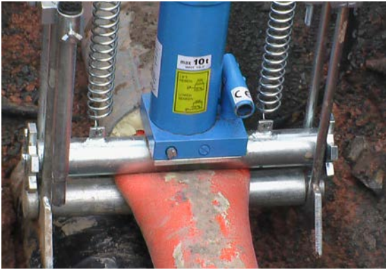
Fig. 07-31 Pressage d'un tuyau caloporteur UNO
