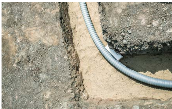
Fig. 07-23 Changements de direction sans raccords
