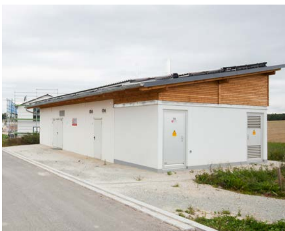
Source de chaleur/Centrale de chauffage
