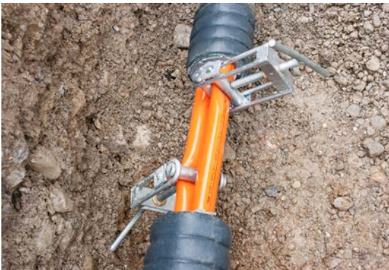
Fig. 07-32 Pressage d'un tuyau caloporteur DUO
