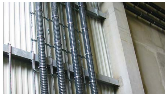
Fig. 07-29 Exemple de pose en extérieur/montage mural
