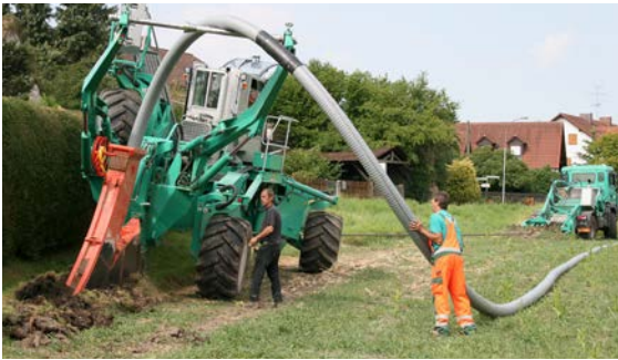
Fig. 07-8 Pose avec enfouissement de tuyau
