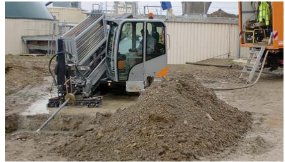
Fig. 07-10 Pose à l'aide d'un appareil de forage dirigé
