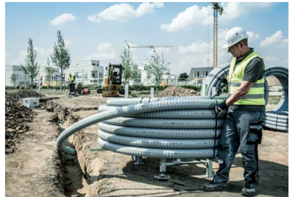
Fig. 07-34 Dérouleur horizontal fixe à l'extrémité de la tranchée
