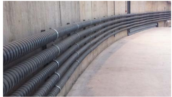
Fig. 07-28 Exemple de pose en extérieur/montage mural
