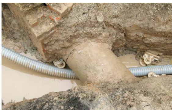
Fig. 07-24 Facilité de pose grâce à l'acheminement flexible des câbles
