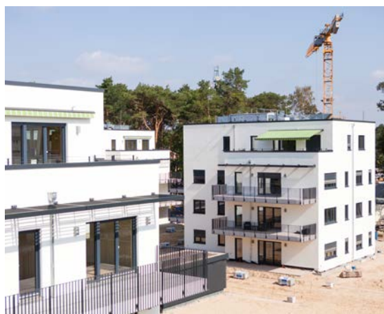
Transmission de chaleur/Raccordement domestique
