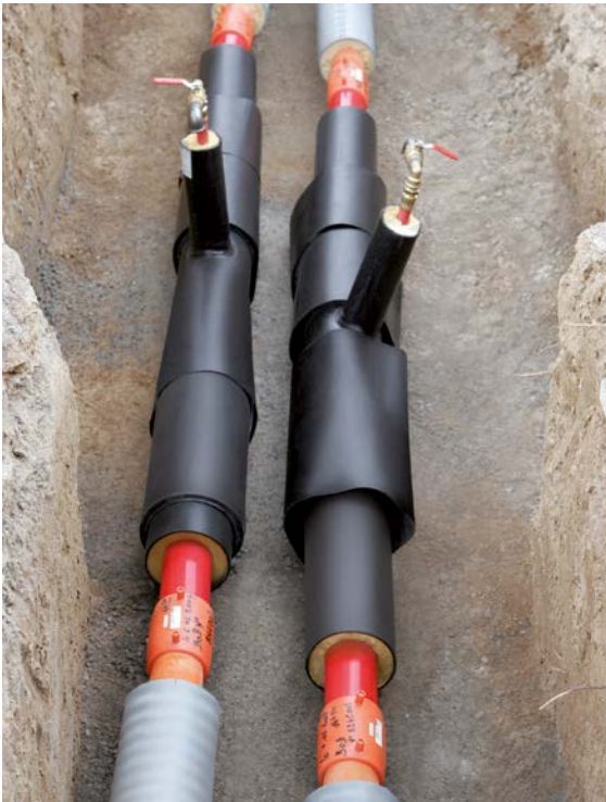
Fig. 07-27 Transitions de tuyaux
