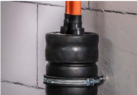
Fig. 05-23 Fermeture de tuyau avec manchette d'extrémité étanche
