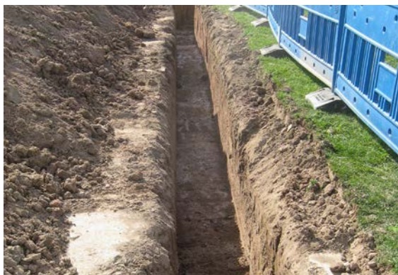
Fig. 07-1 Un fond de tranchée adapté
