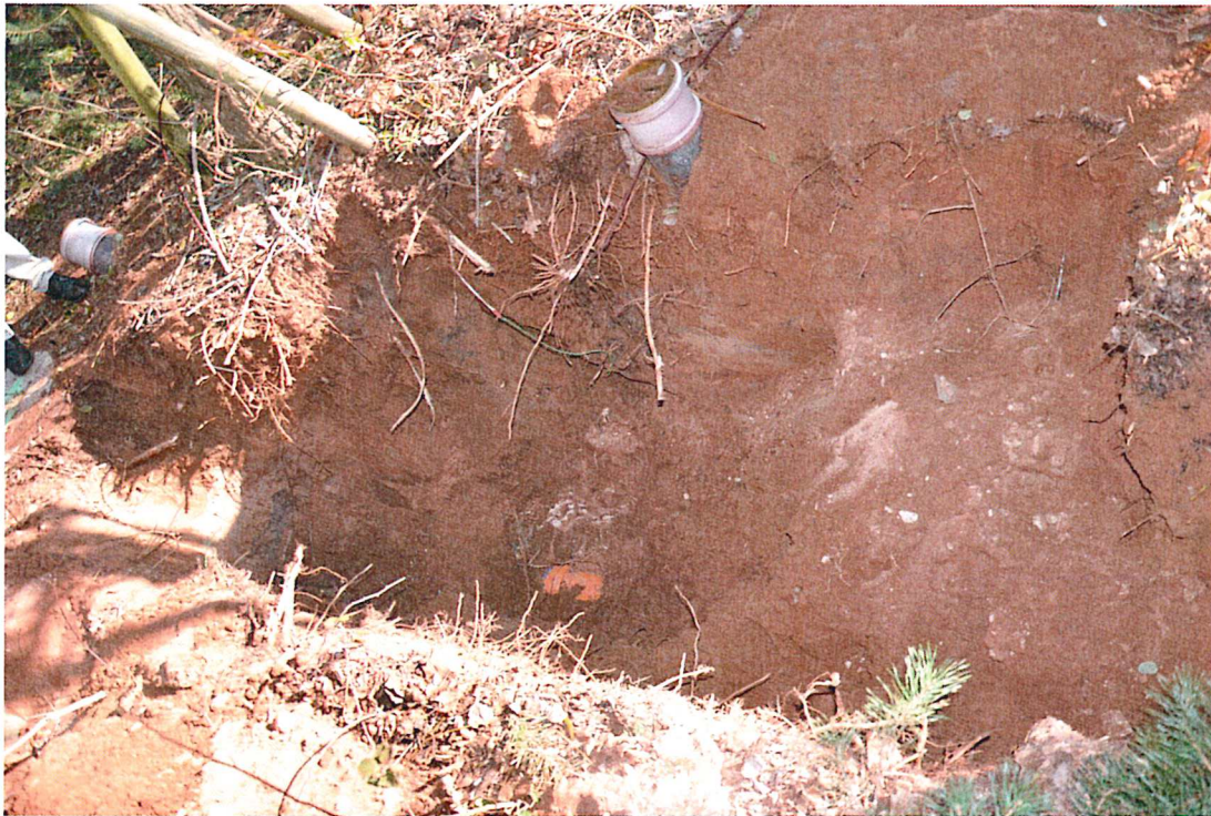
Abb.6: Zustand nach Aufgrabung zwischen Baum B4 und B7 der Kunststoffleitung
