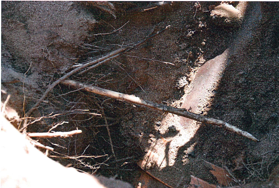
Abb.8: Zustand nach Aufgrabung am Baum B1 der Steinzeugleitung
