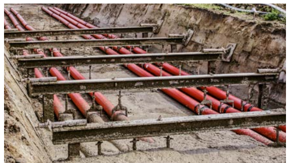
Auftriebssicherung mittels Stahlkonstruktion (Amprion Erdkabel-Pilotbaustelle Raesfeld)
