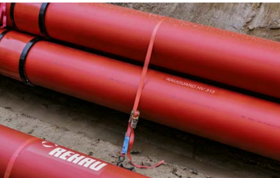
Auftriebssicherung mittels Verankerung im Boden (TenneT Umspannwerk Schacht Audorf)
