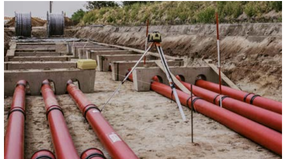
Auftriebssicherung über Betonfertigteile (Amprion Erdkabel-Pilotbaustelle Raesfeld)
