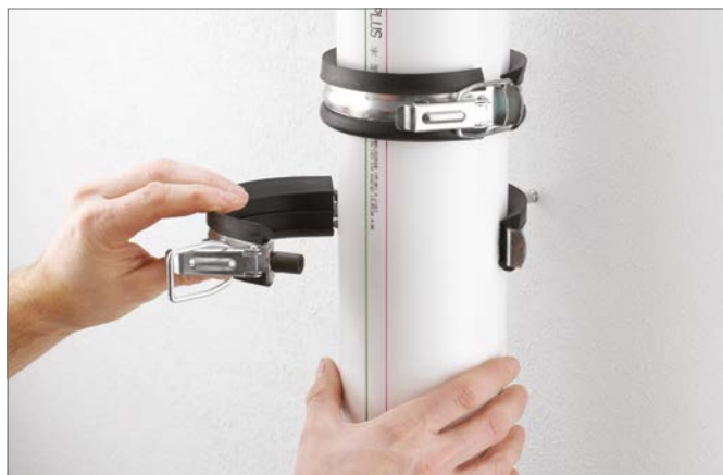
Kuva 7-2 Tukikannakkeen sulkeminen
