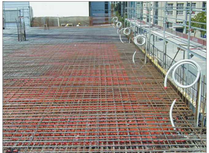
Kuva 8-2 Massiivilaattojen lämmitys/jäähdytysjärjestelmä
