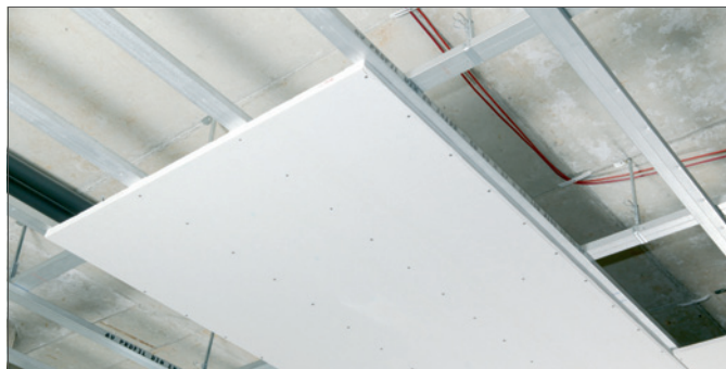
Kuva 4–5 Asennettu kattoelementti
