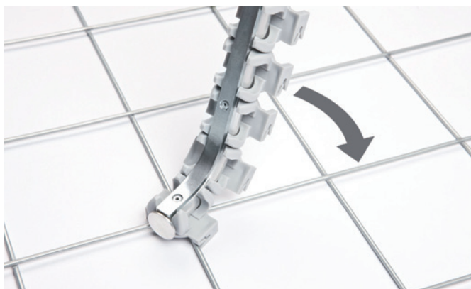
Kuva 3–52 Aseta asennuslaite verkkokiinnikenauhoineen paikalleen
