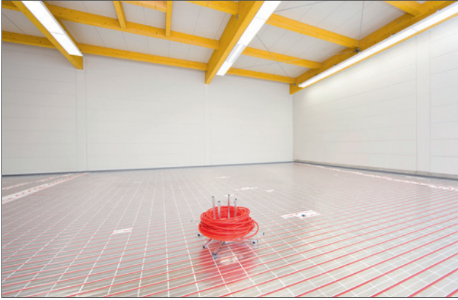
Kuva 10–1 Kuiva-asennusjärjestelmä pistejoustaviin liikuntalattioihin
