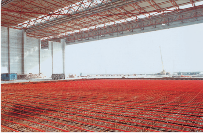
Kuva 9-1 Teollisuushallin lattialämmitys
