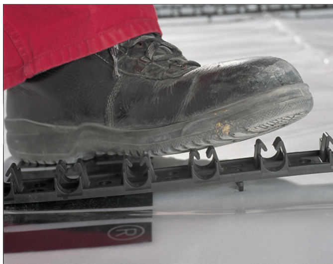
Kuva 3–37 Paina RAUFIX-kisko lattiarakenteeseen
