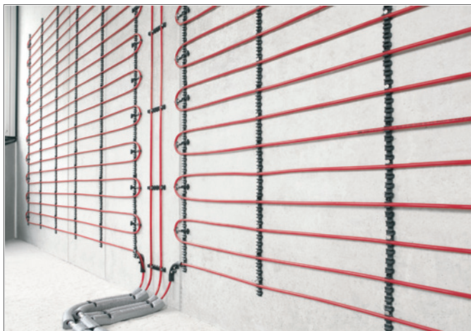
Kuva 4-16 REHAU-seinälämmitys/-jäähdytyslevyt tasoitteessa
