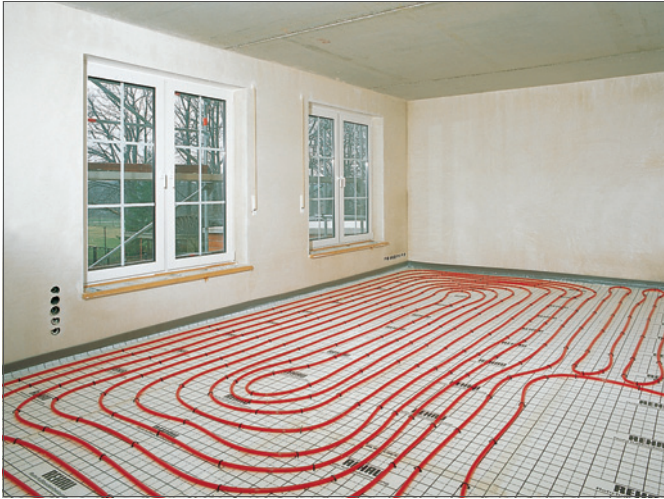
Kuva 3–25 Takkerijärjestelmä
