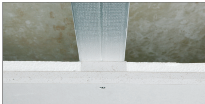
Kuva 4–6 Kattoelementtien kiinnitys
