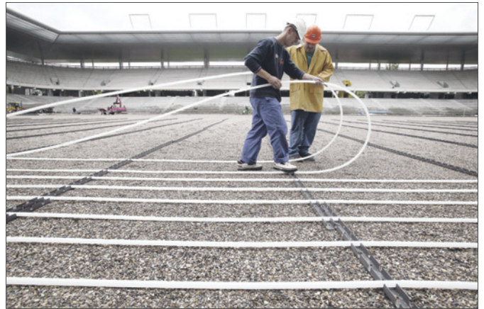
Kuva 12-3 Asenna lämmityspuutket
