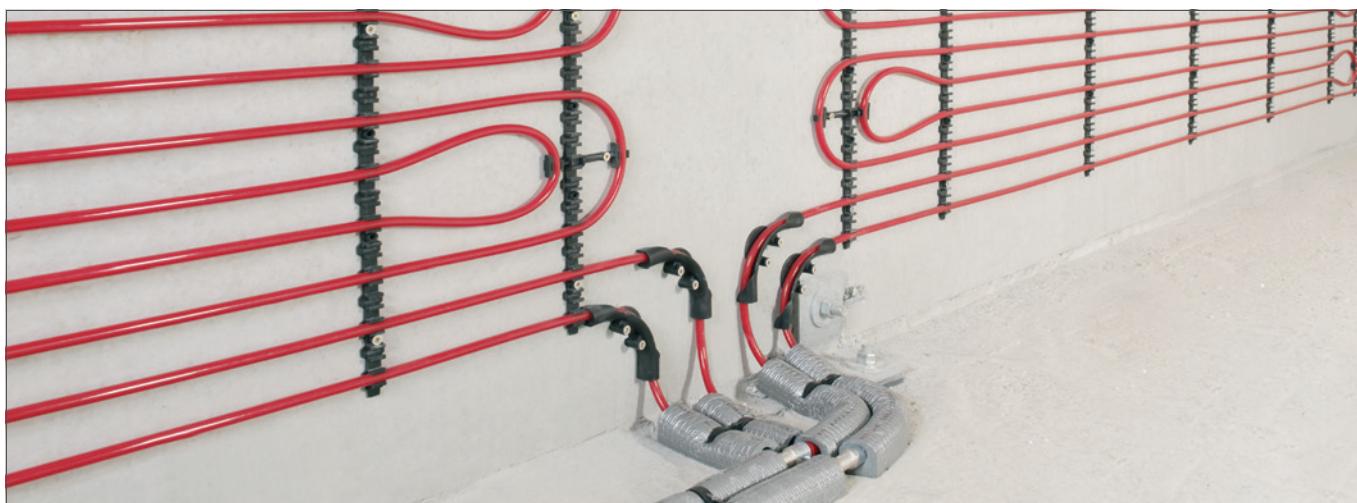
Seinälämmitys/-jäähdytys kuivarakenteessa
