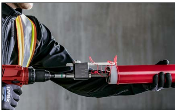
Abb. 03-4 Rotationsschäler mit gleichmäßig hoher Geschwindigkeit rotieren, ein durchgehender Span entsteht. Andernfalls Schneidmesser prüfen und Geschwindigkeit anpassen.
