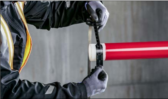
Abb. 03-7 Das für die Verbindung vorbereitete Rohrende mit dem Umfangsmaßband überprüfen soweit erforderlich.
