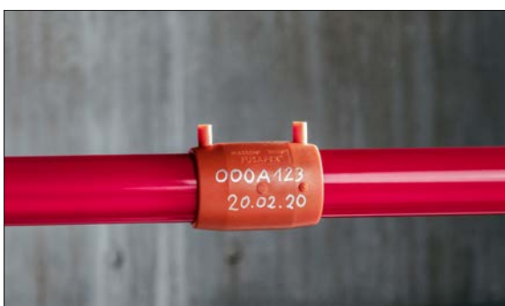
Abb. 03-20 Die Verbindungsherstellung ist abgeschlossen.
