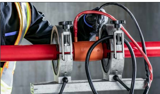
Abb. 03-13 REHAU Schweißgerät mit SMARTFUSE Technologie anschließen, rotes Kabel auf roten Kontakt. Die Schweißparameter werden automatisch erkannt.
