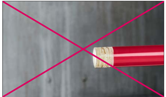
Abb. 03-25 Schweißzone darf weder nass noch verschmutzt sein. Bei der Verarbeitung im Freien ist ggf. ein Zelt aufzustellen.
