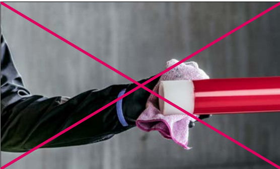
Abb. 03-24 Keine gebrauchten Lappen zum Reinigen einsetzen. Nur wasserfeste, unbenutzte, nicht eingefärbte, fusselfreie und saugfähige Zellstofftücher verwenden.
