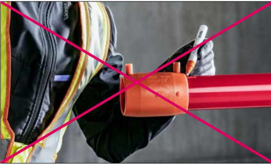
Abb. 03-22 Elektroschweißmuffe nicht zum Anzeichnen verwenden.
