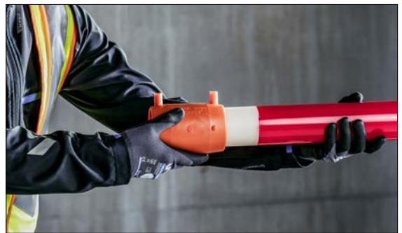
Abb. 03-10 FUSAPEX-Elektroschweißmuffe bis zum Anschlag auf das Rohrende schieben.
