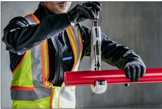
Abb. 03-1 Gewünschtes Maß ablängen. Schnittfläche muss gerade, rechtwinklig zur Rohrachse und gratfrei sein.
