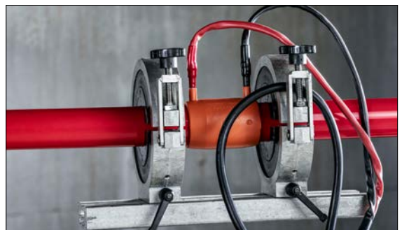
Abb. 03-14 Schweißkabel mittels Schlaufe fixieren um ungewolltes Abziehen zu verhindern.
