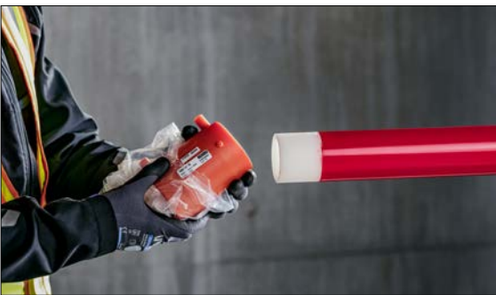
Abb. 03-9 FUSAPEX-Elektroschweißmuffe erst jetzt dem Beutel entnehmen. Wenn erforderlich Schweißmuffe mit Tangit Reiniger innen säubern und diesen komplett verdunsten lassen.
