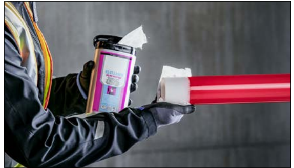
Abb. 03-8 Abschälbereich muss staub- und fettfrei sein. Mit ausreichend Tangit-Reiniger säubern und diesen komplett verdunsten lassen.
