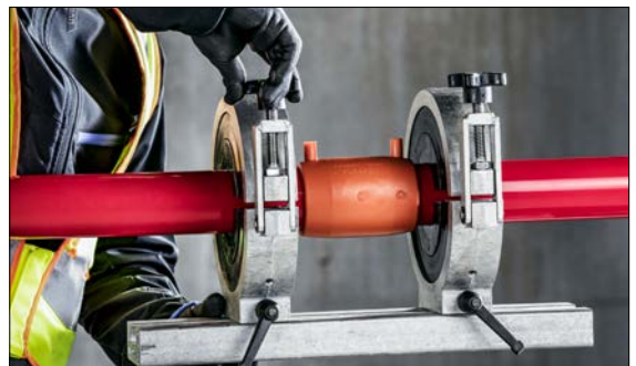
Abb. 03-12 Rohrhalteklemme fixieren. Die Verbindung muss während des Schweißvorgangs spannungsfrei sein.
