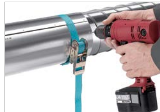
Abb. 56: 2. Vom axialen Dichtungsband ausgehend, erste Bohrung links und rechts durch den Außenmantel der Rohrleitung aufbohren. Bohrl Lochdurchmesser 4,1 mm, Bohrtiefe maximal 10 mm.
