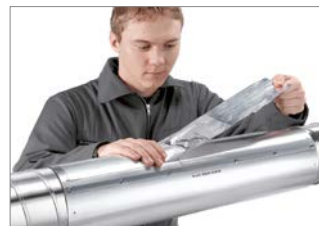
Abb. 73: 9. Entlüftungsöffnungen mit beiliegendem Aluminiumklebeband verschließen. Nach ca. 24 Stunden ist der Schaum ausgehärtet und erreicht seine mechanischen Eigenschaften.
