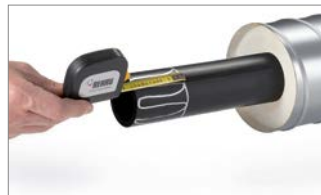
Abb. 22: 2. Abschabzone gemäß Tab. 5 am Basisrohr kennzeichnen.
