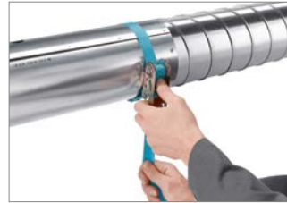
Abb. 83: 9. Isoliermuffe nachspannen und zweite Bohrung links und rechts vernieten. So fortfahren, bis alle Nieten gesetzt sind.
