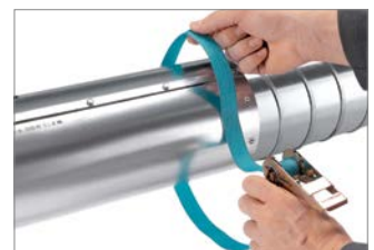
Abb. 59: 5. Die Isoliermuffe entlang der axialen Überlappung mit beiliegenden Bohrschrauben verschrauben und Spanngurte entfernen (siehe Abb. 52 und 53).
