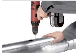
Abb. 63: 3. Verschlussene Einfüllöffnung von Aluminiumband befreien und Entlüftungslöcher (Durchmesser 1 mm) ergänzen.
