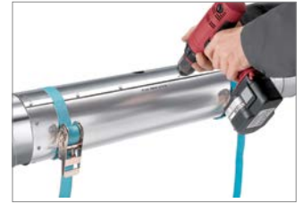
Abb. 84: 10. Die Isoliermuffe entlang der axialen Überlappung mit beiliegenden Bohrschrauben verschrauben. Vorhandene Bohrlöcher verwenden.
