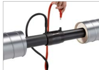
Abb. 30: 10. Schweißgerät anschließen, rotes Kabel auf roten Kontakt.
