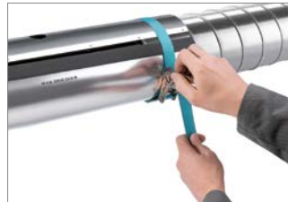
Abb. 50: 5. Isoliermuffe mittig über die Verbindungsstelle schieben und mit ersten Spanngurt neben der äußersten Bohrung fixieren. Die Einfüllöffnung muss senkrecht nach oben stehen.
