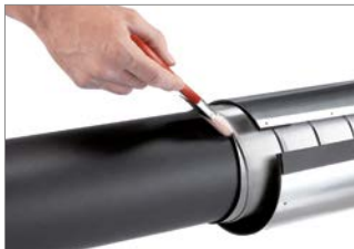
Abb. 77: 3. Vorhandene Spalten verkleben.
