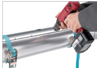
Abb. 52: 7. Die Isoliermuffe entlang der axialen Überlappung mit beiliegenden Bohrschrauben verschrauben. Vorhandene Bohrlöcher verwenden.
