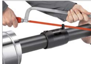
Abb. 48: 3. Die abstehenden Anschlussnippel der Elektroschweißmuffe abtrennen.
