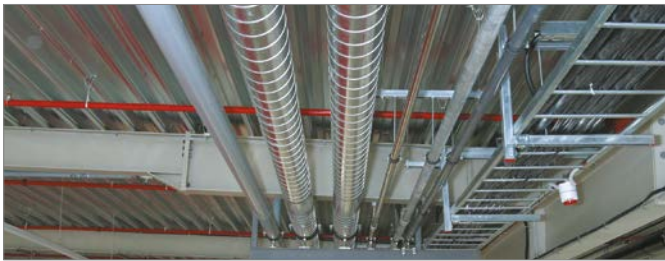
Abb. 89: Montage an der Hallendecke
