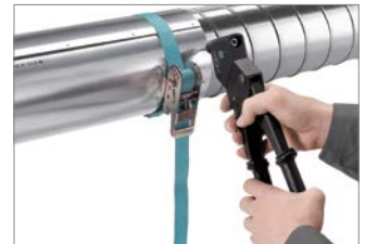
Abb. 57: 3. Isoliermuffe links und rechts mit dem Außenmantel der Rohrleitung vernieten. Typ Mehrbereichs-Blindniet, 4,0 x 10 mm (siehe Preisliste)
