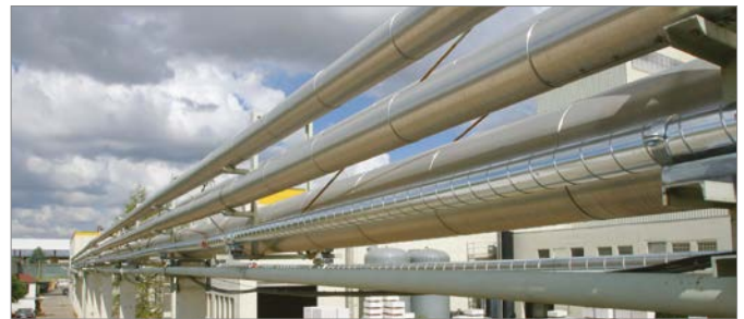
Abb. 92: Freiverlegung, große Stützweite
