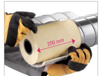
Abb. 18: 4. Aufgetrenntes Wickelfalzrohr entfernen.
