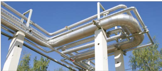
Abb. 91: Freiverlegung, Dehnungsbogen
