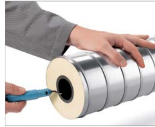
Abb. 15: 1. Rohr an gewünschter Stelle rechtwinklig ablängen und Basisrohr entgraten.
