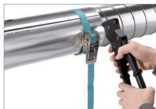
Abb. 82: 8. Isoliermuffe links und rechts mit dem Außenmantel der Rohrleitung vernieten. Typ Mehrbereichs-Blindniet, 4,0 x 10 mm (siehe Preisliste)
