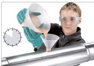
Abb. 69: 5. Reaktionsgemisch in Isoliermuffe gießen, bei Bedarf Trichter verwenden.
