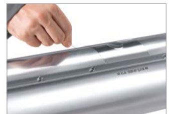
Abb. 72: 8. Ausgetretenen, erhärteten Schaum entfernen. Überprüfen, ob Isoliermuffe vollständig mit Schaum gefüllt ist.
