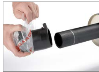
Abb. 26: 6. Elektroschweißmuffe aus dem PE-Beutel entnehmen.
