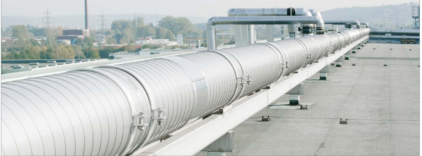
Abb. 88: Sonderausführung RAUFRIGO mit Außenmantel aus Edelstahl
