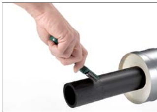
Abb. 23: 3. Abschabzone beider Rohrenden mittels Rotationsschäler oder Handschaber spanabhebend bearbeiten (Spandicke ≈ 2 mm).
