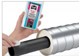
Abb. 24: 4. Abschabbereich (Schweißzone) muss fett- und staubfrei sein; notfalls mit Tangitreiniger für PE säubern. Reiniger komplett verdunsten lassen.
