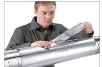
Abb. 86: 12. Entlüftungslöcher und Einfüllöffnung mit beiliegenden Aluminiumklebeband verschließen.
