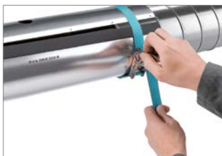
Abb. 79: 5. Isoliermuffe mittig über die Verbindungsstelle schieben und mit erstem Spanngurt neben der äußersten Bohrung fixieren. Die Einfüllöffnung muss senkrecht nach oben stehen.
