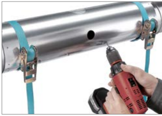
Abb. 61: 1. Wenn die Verschraubung von oben nicht möglich ist, kann die Isoliermuffe 90° gedreht werden, um sie von unten zu verschrauben.
