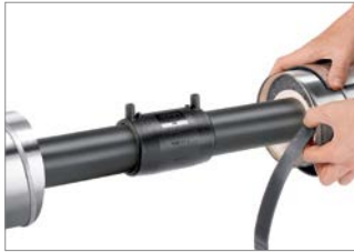
Abb. 75: 1. Stirnseitig vertiefte Isolierschaumflächen der RAUFRIGO Rohre mit zugeschnittenen Dämmstreifen verschließen.
