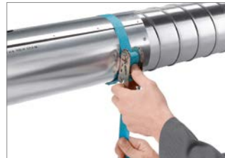
Abb. 58: 4. Isoliermuffe nachspannen und zweite Bohrung links und rechts vernieten. So fortfahren, bis alle Niete gesetzt sind.
