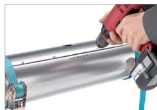
Abb. 59: 5. Die Isoliermuffe entlang der axialen Überlappung mit beiliegenden Bohrschrauben verschrauben und Spanngurte entfernen (siehe Abb. 52 und 53).
