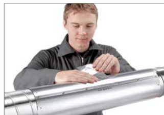
Abb. 70: 6. Einfüllöffnung sofort mit beiliegendem Aluminiumklebeband (100 x 150 mm) verschließen.
