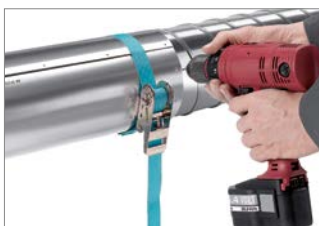
Abb. 81: 7. Vom axialen Dichtungsband ausgehend, erste Bohrung links und rechts durch den Außenmantel der Rohrleitung aufbohren. Bohrl Lochdurchmesser 4,1 mm, Bohrtiefe maximal 10 mm.
