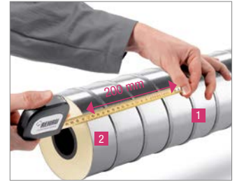
Abb. 16: 2. Abisolierlänge 1 und Trennkante 2 anzeichnen.
