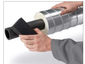
Abb. 20: 6. Polyurethanrückstände entfernen.
