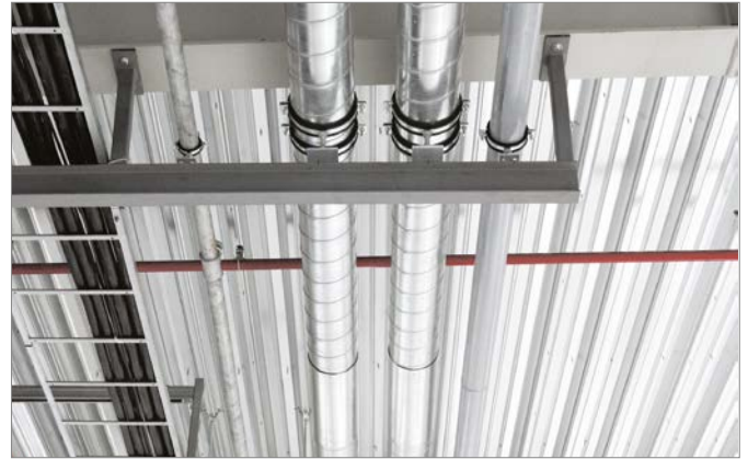
Abb. 87: Abhängung an der Hallendecke
