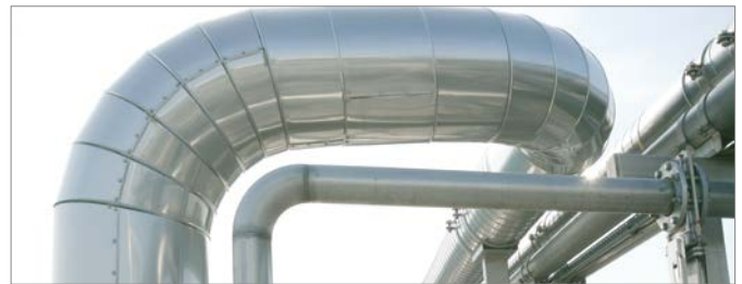
Abb. 90: Bogen, nachisoliert
