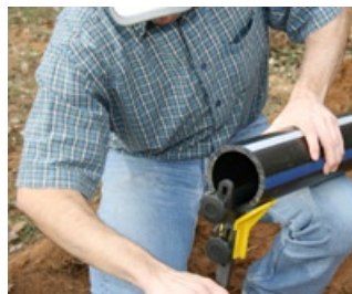
1. Anfasen des Rohrendes mittels geeignetem Werkzeug
