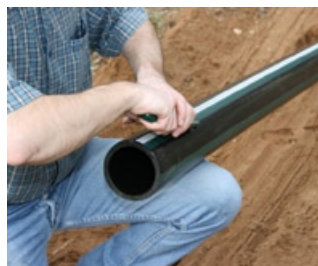
2. Einebnen des REHAU Barcodekennzeichnungsstreifens.
