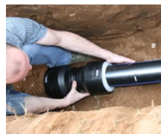
6. Steckkupplung fluchtend auf das Rohrende schieben.
