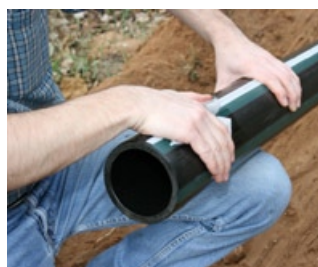
3. Reinigen der Rohroberfläche, eventuell ist TANGIT Kunststoff-Spezialreiniger zu verwenden.
