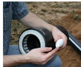
5. Lippendichtung mit handelsüblichem Gleitmittel (Trinkwasser-Qualität) einstreichen.
