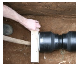
7. Steckkupplung mittels Montagehilfe bis zum Erreichen der Einsteckmarkierung aufschieben.
