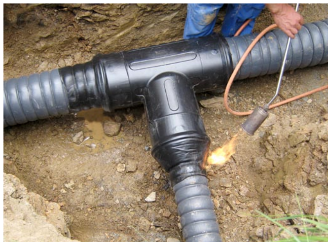
Durch das Abschrumpfen der Schrumpfschläuche wird die Muffe sicher abgedichtet.
