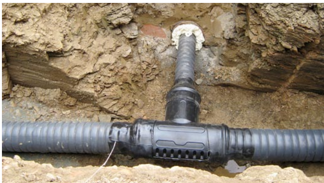
Das speziell isolierte Muffensystem mindert Wärmeverluste.
