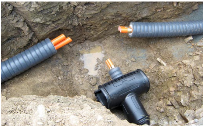
Die Muffe kann schnell und einfach auf der Baustelle gehandhabt werden.
