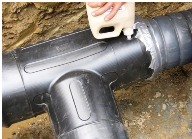
Zur Dämmung wird ein hochwertiger Zweikomponenten-PU-Schaum eingesetzt.
