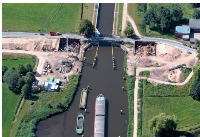
Luftaufnahme des Baustellenbeginns Projekt Berkenthin
