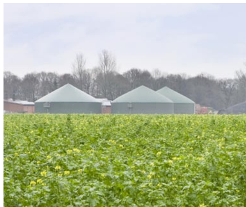
Ökologische Wärmeversorgung der Samtgemeinde Lathen (Deutschland) durch die Abwärme von Biogasanlagen
