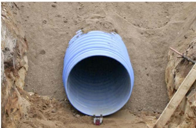
Das Einbringen der Hauptverfüllung erfolgt lagenweise mit Schichtdicken von etwa 30 cm.
