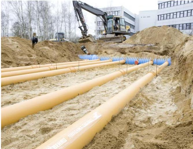
Anschluss der Wärmetauscherrohre AWADUKT Thermo antimikrobiell DN 250 an vorkonfektionierten-polypropylen Verteilerbalken
