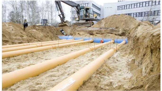
Die Bauteile und Dichtringe sind vor dem Einbau auf Beschädigungen zu prüfen. Bauteile dürfen nicht in den Rohrgraben/Verlegebereich geworfen werden.
