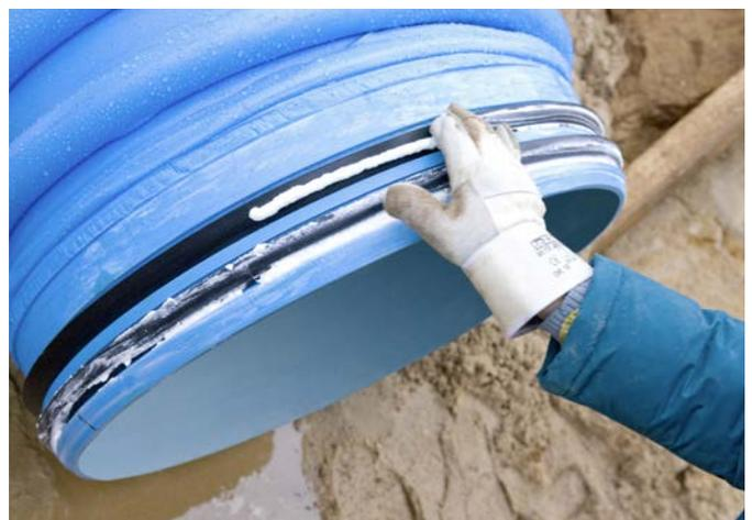
Unmittelbar vor der Verbindung von zwei Bauteilen sind die Schutzvorrichtungen an den Bauteilenden zu entfernen und der Muffen- und Spitzendenbereich auf Beschädigungen hin zu prüfen.
