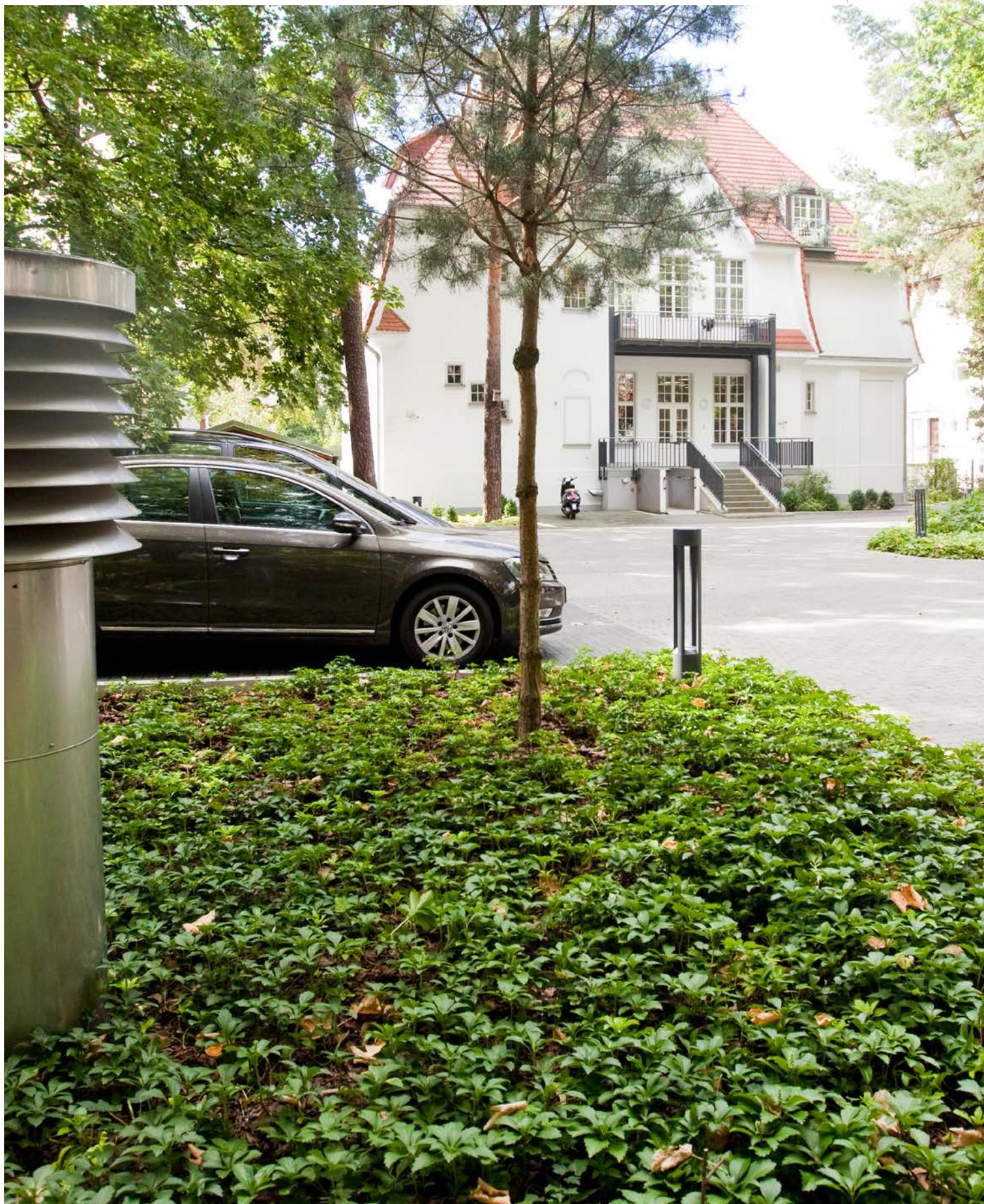
Sie können die Luft, die Sie für ein Gebäude brauchen, direkt durch Rohre ansaugen und im Gebäude verteilen. Aber auch indirekt und intelligent durch ein erdverlegtes Netz aus Rohren leiten und damit Energie einsparen. Viel Energie: Im Sommer wird die Luft so vorgekühlt, im Winter vorgeheizt. Sie müssen die Lüftungsluft im Winter weniger erwärmen und im Sommer weniger kühlen.
