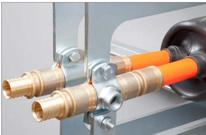
Abb. 6: Fixierung der Mediumrohre am Hausanschluss
