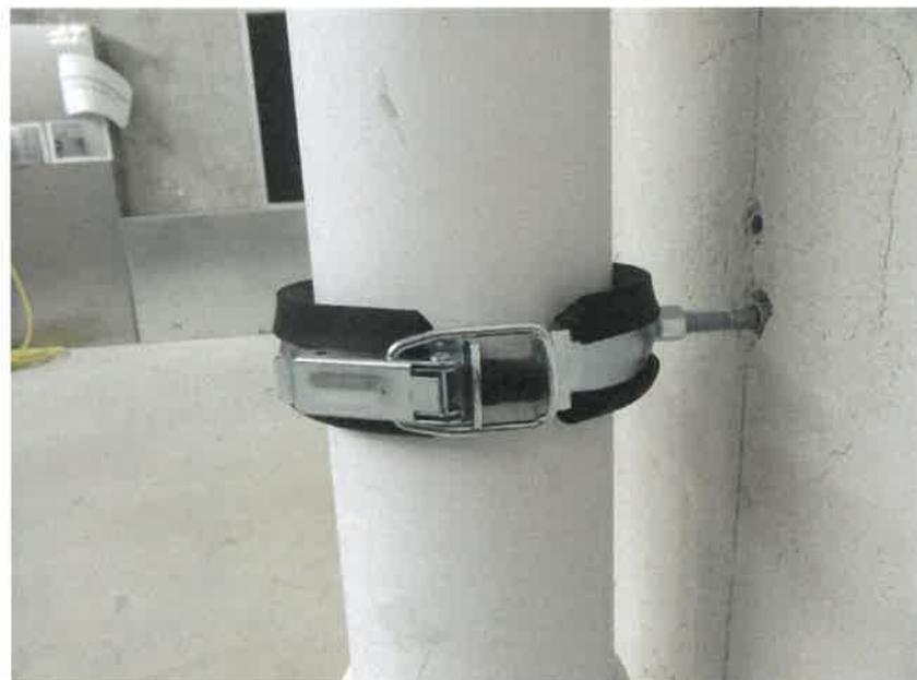
Bild oben: Abwassersystem mit "körperschalldämmenden Stützbefestigung" im oberen Wandbereich.
