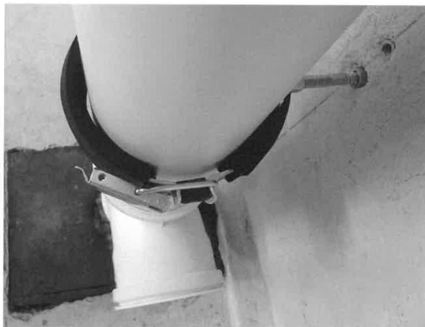
Bild oben: Abwassersystem mit Festschelle im oberen Wandbereich.
