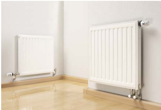
Afb. 18-1 Radiatoraansluiting vanuit de plint
