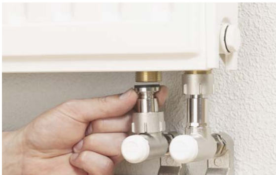
Afb. 18-8 Aansluiting telescopische hoekkoppelsset
