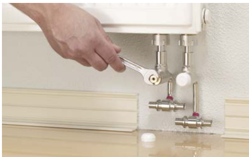
Afb. 18-12 Klemringkoppeling vastdraaien
