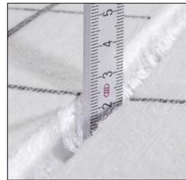
Abb. 04-139 Nuttiefe 20 mm zwischen Oberkante Dämmung und Nutscheitel
