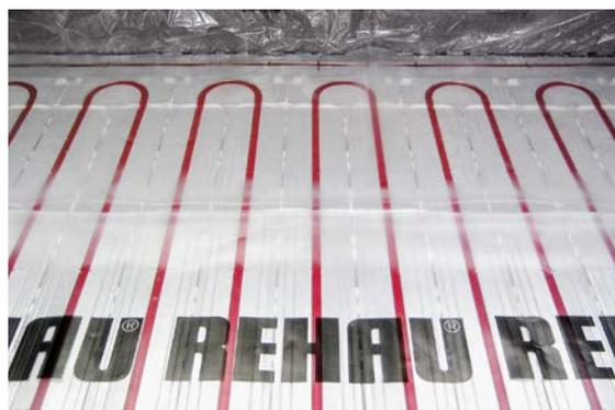
Abb. 04-173 Trockensystem TS-14
