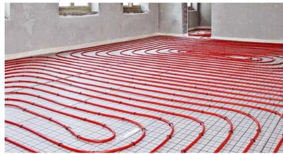
Abb. 04-78 System Tackerplatte
