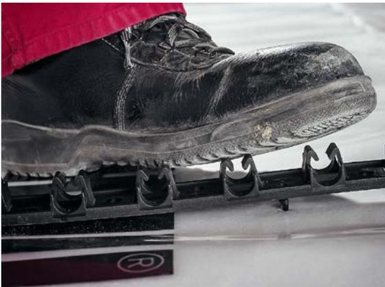
Abb. 04-130 RAUFIX-Schiene in Fußbodenaufbau drücken
