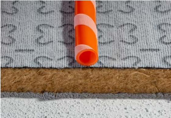
Abb. 04-47 Fußbodenaufbau mit zusätzlicher Trittschalldämmung
