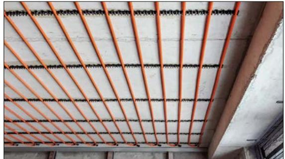
Abb. 06-26 System Deckenheizung/-kühlung in Nassbauweise
