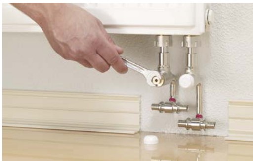
Fig. 19-12 Stringere il collegamento a vite con anello di serraggio
