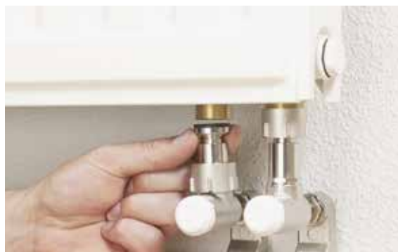
Fig. 18-8 Attacco del set di collegamenti a vite angolari telescopici
