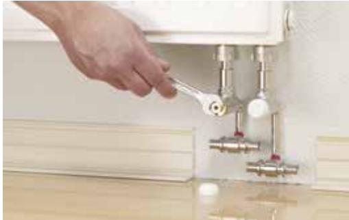
Fig. 18-12 Stringere il collegamento a vite con anello di serraggio
