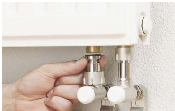
Fig. 19-8 Attacco del set di collegamenti a vite angolari telescopici
