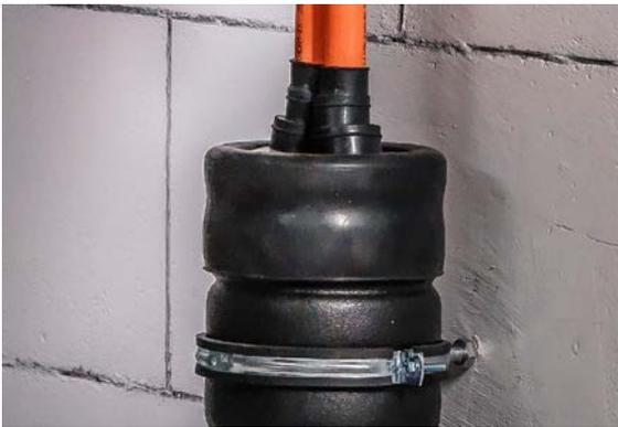
Fig. 05-23 Fermeture de tuyau avec manchette d'extrémité étanche
