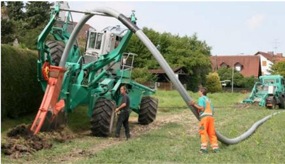
Fig. 07-8 Pose avec enfouissement de tuyau
