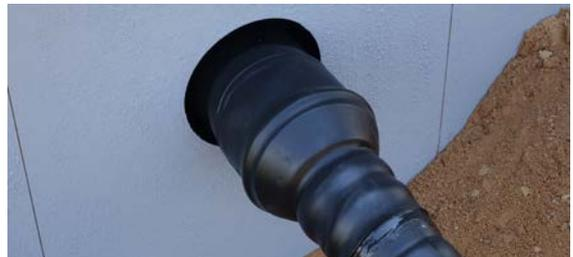
Fig. 05-16 Exemple de montage du kit de passage mural avec gaine thermorétractable et joint de chaîne à maillons
