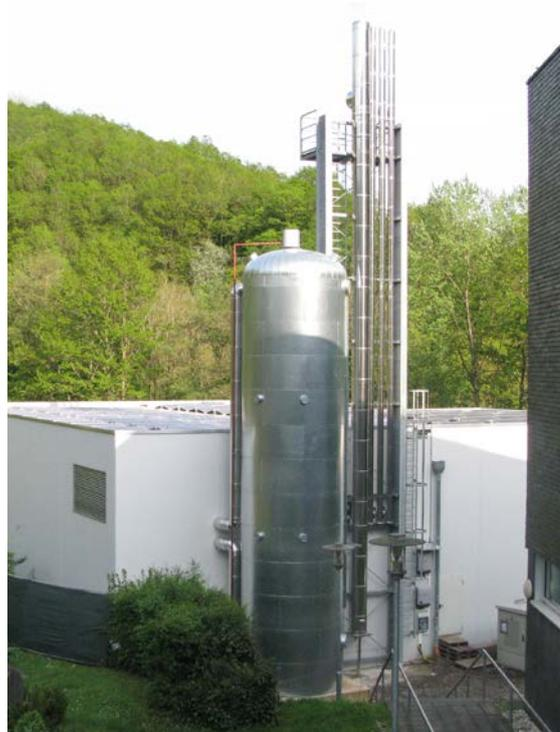
Fig. 06-8 Accumulateur de chaleur centralisé
