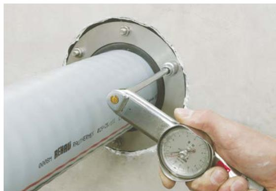
Fig. 05-12 Montage avec clé dynamométrique
