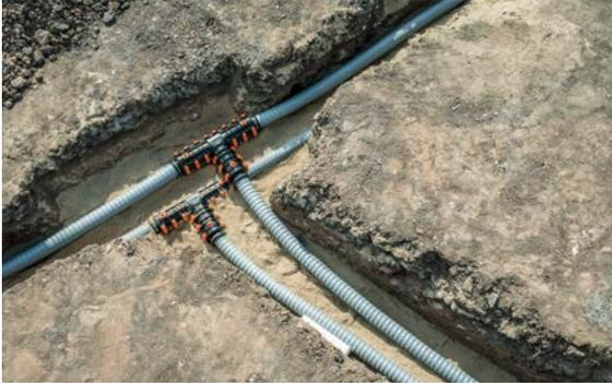
Fig. 07-4 Pose en mode de construction ouverte
