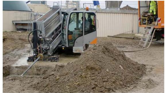
Fig. 07-10 Pose à l'aide d'un appareil de forage dirigé
