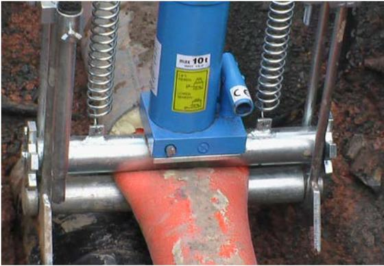
Fig. 07-31 Pressage d'un tuyau caloporteur UNO
