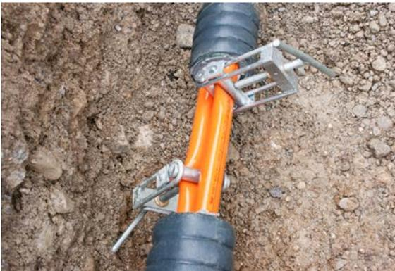
Fig. 07-32 Pressage d'un tuyau caloporteur DUO
