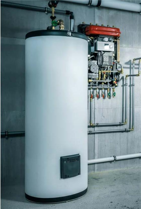
Fig. 06-9 Accumulateur de chaleur décentralisé
