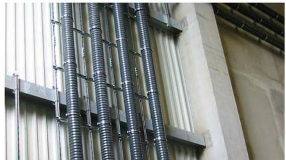
Fig. 07-29 Exemple de pose en extérieur/montage mural
