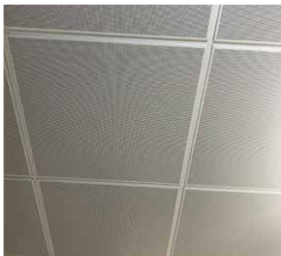
Riscaldamento/raffrescamento a soffitto ispezionabile e modulare
