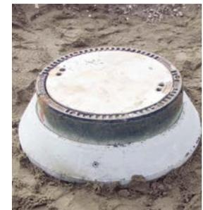
24 Punktlasten zwischen Hybridauflagering und Abdeckung sind zu vermeiden. Hierzu ist die Abdeckung auf eine 1 cm dicke Schicht Ausgleichsmörtel zu setzen. Siehe Einbauskitze nächste Seite.
