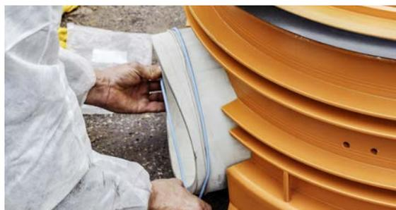
9 Die mitgelieferten Quelldichtungen (graue eckige Dichtung) auf alle PP Rohrstutzen am AWASCHACHT Boden aufziehen. Die Dichtungen sind hinter der Wulst zu platzieren. Dichtungsdurchmesser laut Herstellervorgabe verwenden (siehe Verpackung Quelldichtung). Auf der Altschachtseite müssen ebenfalls Quelldichtungen aufgezogen werden. Ist dies nicht möglich muss Quelpaste aufgetragen werden. Hierzu Einbauvorgaben zu Quellmaterial beachten (Seite 183).
