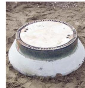
16 Punktlasten zwischen Hybridauflagering und Abdeckung sind zu vermeiden. Hierzu ist die Abdeckung auf eine 1 cm dicke Schicht Ausgleichsmörtel zu setzen. Siehe Einbauskitze nächste Seite.
