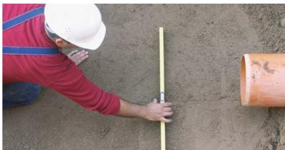
1 Auflagerbereich des Schachtbodens gem. DIN EN 1610 vorbereiten. Der Untergrund muss tragfähig und eben sein. Dazu eine mind. 10 cm dicke Bettungsschicht (z. B. Sauberkeitsschicht) erstellen.
