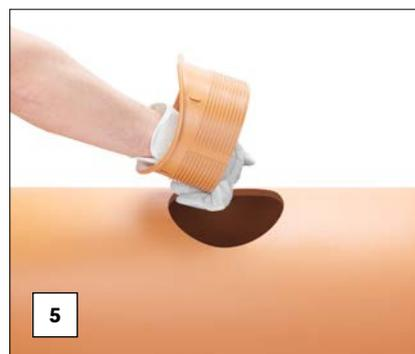
3. Zentrierbohrer in die vorgebohrte Bohrung einführen. Bohrung mit Lochsäge/Bohrkrone im 90° Winkel zur Rohrachse. Wir empfehlen hierfür unser Bohrstativ. Durchmesser Bohrung: 162 mm  $\pm$  1 mm bzw. 200 mm  $\pm$  1 mm.
