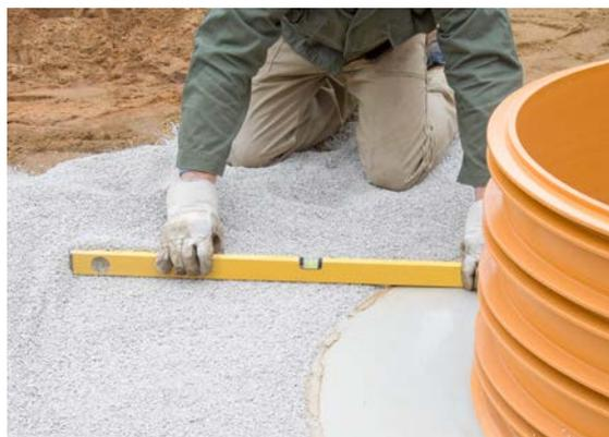
4.2 Die Bettungsoberfläche für die Stahlbeton-Lastverteilplatte muss plan ausgeführt werden und darf keine Punktlasten übertragen. Hierfür ist eine ca. 20 cm breite Schicht Feinsplitt (ggf. Sand) aufzutragen, deren Oberfläche auf gleicher Höhe wie die Oberseite der Übergangsplatte ist.
