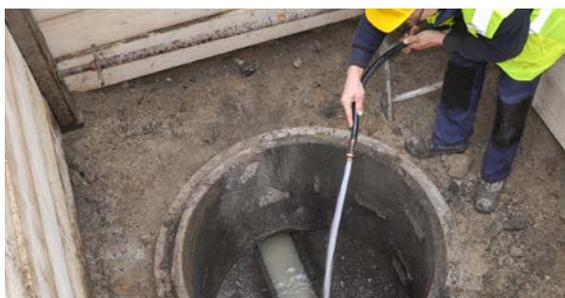
3 Die Betonschachtringe reinigen und ggf. gegen eindringendes, fließendes Wasser abdichten.
