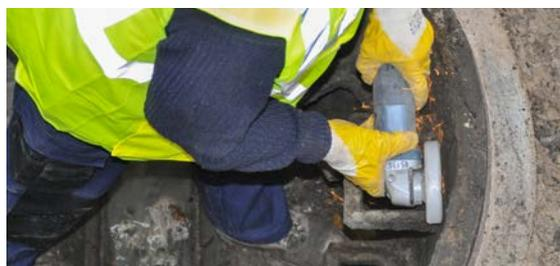
5 Die Steigstufen bzw. Steigeisen des Altschachtes entfernen.
