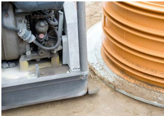
4.1 Zum Verfüllen des Schachtbodens DN 1200/DN 1500 ist Boden der Gruppe G1 oder G2, max. Korngröße 32 mm (abgestufter Boden mit Feinanteilen) zu verwenden. Empfehlung: Verwendung von Recyclingmaterial. Verfüllmaterial in einer Breite von 40 cm (bei Einbau der Schächte in Grundwasser mind. 60 cm) sorgfältig und lagenweise in Schichtdicken von 20 bis 40 cm einbringen und gemäß den Vorgaben der DIN EN 1610, ATV-DVWK-A 139 verdichten. Verdichtungsgrad  $D_{pr}$  97%.
