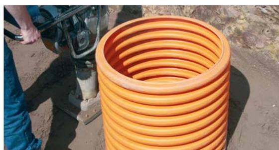
5 Zum Verfüllen der Schachtbauteile ist Boden der Gruppe G1 oder G2, max. Korngröße 16 mm (abgestufter Boden mit Feinanteilen) zu verwenden. Empfehlung: Verwendung von Recyclingmaterial. Verfüllmaterial in einer Breite von 40 cm (bei Einbau der Schächte in Grundwasser mind. 60 cm) sorgfältig und lagenweise in Schichtdicken von 20 bis 40 cm einbringen und gemäß den Vorgaben der DIN EN 1610, ATV-DVWK-A 139 verdichten. Verdichtungsgrad im Bereich von Verkehrsstraßen  $D_{Pr} \geq 97\%$ .
