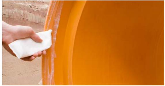
7 Die Muffe des aufzusetzenden Schachtrings säubern und gleichmäßig mit Gleitmittel einstreichen. (Einbautipp: Die Dichtung nicht mit Gleitmittel einstreichen.) Es ist darauf zu achten, dass die Muffe auch nach dem Einstreichen keine Verschmutzung aufweist.
