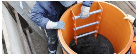
4 Sobald der Vergussmörtel ausgehärtet ist, können die Absperrblasen entfernt werden. Danach wird der Schachtring aufgesetzt. Der Ringspalt wird mit fließfähigem Mörtel verfüllt.
