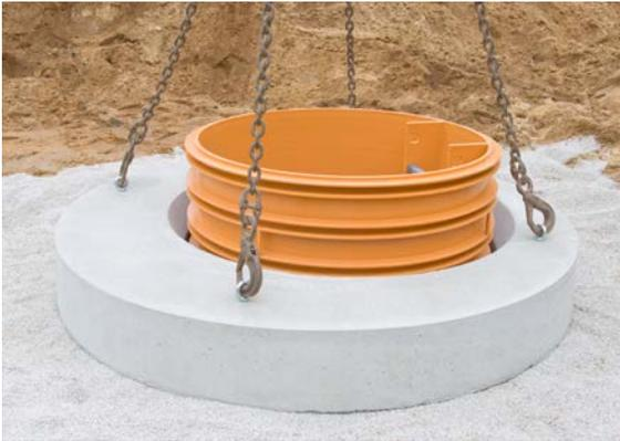
4.4 Stahlbeton-Lastverteilplatte unter Verwendung von Ringschrauben vorsichtig auf die Feinsplittschicht absetzen.
