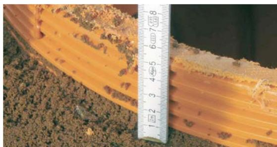
21 Die Verfüllung/Einbettung des Schachtbauwerks wird bis 5 - 6 cm unterhalb der Oberkante des gekürzten Konus (OKgK) hergestellt (siehe Einbauskitze auf Seite 184). Die Bettungsoberfläche muss plan ausgeführt werden und darf keine Punktlasten an den Hybridauflagering übertragen (ggf. Feinsplitt oder Mörtelschicht einbringen). Empfehlung: Abziehhilfe verwenden, um den Bettungsbereich für den Hybridauflagering eben und plan zu gestalten.
