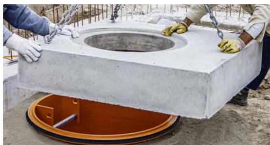
14 Betonabdeckplatte waagrecht und zentrisch über den Schacht-ring heben und auf den vorbereiteten Untergrund absetzen. Die Einstiegsöffnung ist zu den Leitersprossen auszurichten. Bei korrekter Montage sollte im Inneren des Schachts zwischen Oberkante Schachtring und Betonabdeckplatte ein Spalt von 30 – 50 mm sein.
