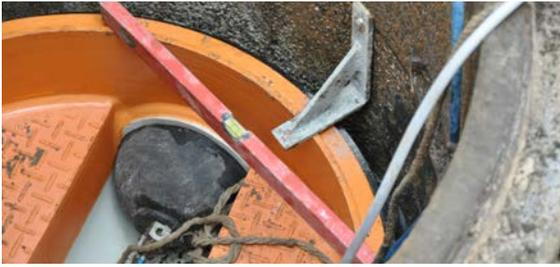
12 Als Auftriebssicherung für den Verfüllvorgang mind. drei Stahlwinkel an der Wand montieren. Es ist darauf zu achten, dass diese gleichmäßig über den Umfang des Sanierungsschachtbodens verteilt sind.
