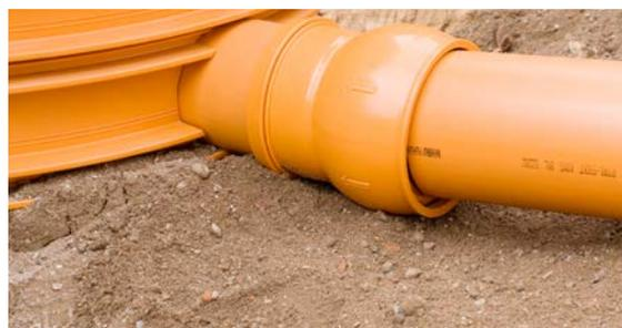
4 Rohr am Zulauf in den Schachtboden einstecken. Hinweise zum Steckvorgang beachten, siehe Punkt 2. Anschließend das Rohr entsprechend der Leitungsführung ausrichten. Mit den Gelenkmuffen/Kugelgelenken können sowohl Gefällewechsel als auch eine Richtungsänderung bis zu 7,5° nach links/rechts realisiert werden. Bei gleichzeitigem Gefällewechsel und Richtungsänderung können sich die Werte der Auslenkung reduzieren.
