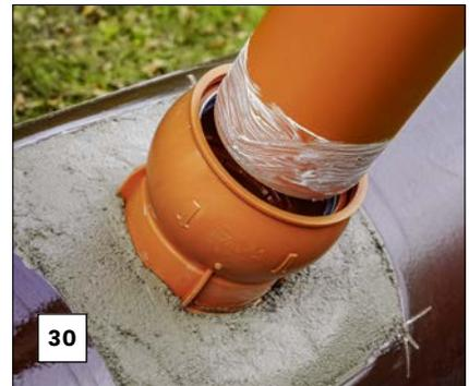
28. Estrichbeton herstellen, um das Montagefenster zu verfüllen.
