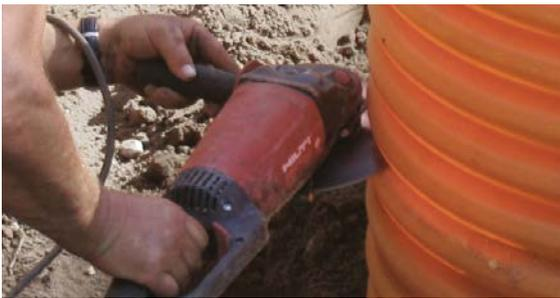
6.1 Falls erforderlich, ist das Steigrohr unter Beachtung der Gesamthöhe des Schachtes zu kürzen. Es ist dabei zu beachten, dass der Schnitt auf einem Wellenberg erfolgt, wobei die Überlappung mit dem BAR mindestens 7 cm betragen muss. Das Steigrohr darf sich jedoch maximal 13 cm mit dem BAR überlappen. Es muss ein komplettes Wellental für die Dichtung vorhanden sein. Die Schnittfläche ist zu entgraten.
