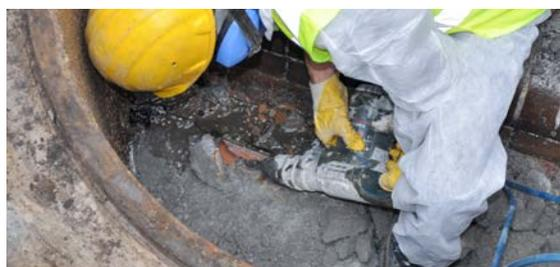
6 Das vorhandene Gerinne und die vorhandene Berme so weit ausstemmen, bis die Rohrstützen des Schacht-in-Schacht (SiS)-Schachtbodens sohlgleich zu den Bestandsrohren sitzen. Es ist darauf zu achten, dass die Schachtsohlplatte nicht zu tief ausgestemmt wird, um möglichen Grundwassereintritt zu vermeiden. Falls notwendig einragenden Altrohrstützen kürzen. Es ist darauf zu achten, dass das Rohr dabei nicht bricht oder reißt und die Quelldichtung noch aufgezogen werden kann.
