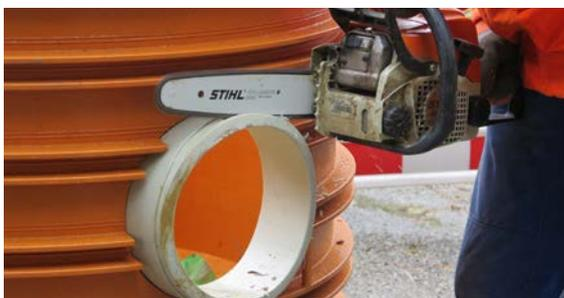
Der Rohrstutzen kann bei Bedarf abgesägt werden, um das Ausrichten des Schachtes zu erleichtern.
