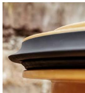
6 Elementdichtung mit der Schrift nach oben in die Dichtkammer einlegen und anschließend auf Beschädigungen und richtigen Sitz prüfen sowie von Verschmutzungen befreien.
