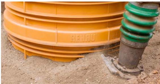
9 Zum Verfüllen der Schachtbauteile ist Boden der Gruppe G1 oder G2, max. Korngröße 63 mm (abgestufter Boden mit Feinanteilen) zu verwenden. Empfehlung: Verwendung von Recyclingmaterial. Verfüllmaterial in einer Breite von 40 cm (bei Einbau der Schächte in Grundwasser mind. 60 cm) sorgfältig und lagenweise in Schichtdicken von 20 bis 40 cm einbringen und gemäß den Vorgaben der DIN EN 1610, ATV-DVWK-A 139 verdichten. Verdichtungsgrad im Bereich von Verkehrsstraßen  $D_{Pr} \geq 97\%$ .
