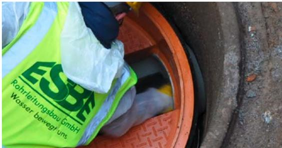
7 Den Sanierungsschachtboden (zunächst ohne Dichtungen) in den Betonschacht herablassen und die Passung des Sanierungsschachtbodens mit den Anschlussrohren prüfen (Sohlhöhe und Winkel). Ggf. das Altgerinne weiter ausstemmen oder den SiS-Schachtboden anheben bzw. unterfüttern. Diesen Vorgang ggf. mehrfach wiederholen. Die Gerinnesohle vom Schachtboden muss schließlich auf der gleichen Höhe wie die Sohle der Bestandsrohre liegen.
