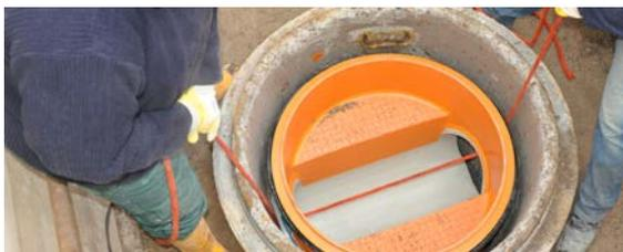
2 Nachdem die Schachtelementdichtung und Anschlussdichtungen montiert wurden, wird der Sanierungsschachtboden in den Betonschacht herabgelassen.
