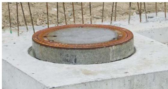
15 Je nach Bauhöhe der vorhandenen Schachtabdeckung sind zur Anpassung an die GOK ggf. Betonausgleichsrings unterschiedlicher Höhe zu setzen. Bei sehr / zu geringer Ausgleichshöhe ist es zuvor erforderlich den Schachtring um exakt 125 mm zu kürzen (siehe Punkt 11). Anschließend Betonausgleichsring(e) und Schachtabdeckung auf Ausgleichsmörtelschicht setzen. Die Anzahl der Betonausgleichsrings für den Höhenausgleich ist zu minimieren.
