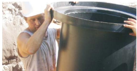
6.3 Die Dichtung für das Teleskop ist an der Innenseite des Steigrohres zwischen der ersten und zweiten Welle zu montieren. Teleskop in das Steigrohr einschieben (Gleitmittel verwenden). Beim Ausrichten des Teleskops gem. Geländeoberkante ist darauf zu achten, dass das Teleskop mind. 14 cm in das Steigrohr einragen soll. Das Teleskop ist je nach Belastungsfall tragfähig zu gründen. Danach die Abdeckung DN 600 Kl. A oder B in das Teleskop legen.
