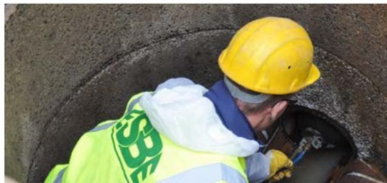
4 Den Durchfluss von Abwasser stoppen. Dazu die Absperrblasen in die Abgänge einsetzen (Tipp: Absperrblasen im nächsten Schacht (zulaufseitig) einsetzen, um die Arbeiten im Sanierungsschacht zu erleichtern).
