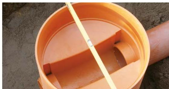
3 Die Ausrichtung des Schachtbodens ist zu überprüfen (Das Gefälle des Schachtgerinnes beträgt 0%).
