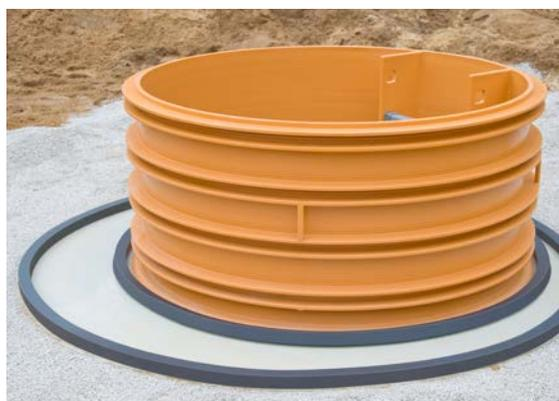
4.3 Im Lieferumfang befindet sich je eine Rechteckdichtung für den äußeren Umfang der Übergangsplatte sowie eine Dichtung entlang des Umfangs der aufsteigenden Schachtringe DN 1000. Übergangsplatte sorgfältig reinigen und anschließend die beiden Rechteckdichtungen aufkleben. Gegebenenfalls sind die Dichtungen bereits auf der Unterseite der Lastverteilplatte aufgeklebt.
