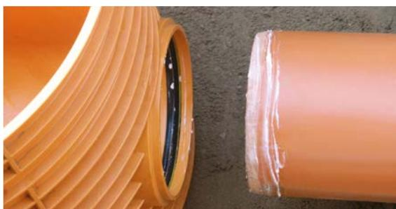
2 Schachtboden gemäß Planungsvorgaben auf die vorgesehene Höhe setzen, ausrichten und entsprechend den Anschlussrohren positionieren. Steckvorgang: Das Gleitmittel ist auf das Spitzende aufzutragen, die Anschlussdichtungen sind vor dem Stecken auf ordnungsgemäßen Sitz zu überprüfen und von Verunreinigungen zu säubern. Rohr und Schacht bis zum Anschlag zusammenschieben.
