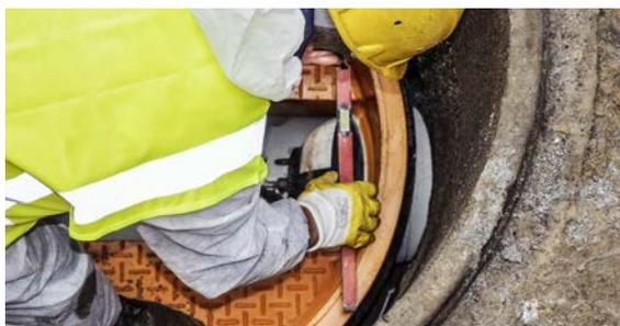
11 Das Anschlussrohr reinigen, bevor die Absperrblasen gesetzt werden. Die Absperrblasen sind an jedem Zu- und Auslauf zu setzen. Sie dienen als Zentrierung der Anschlussstutzen des neuen Schachtgerinnes zu den vorhandenen Altrohren und als Schalung für den Vergussmörtel.
