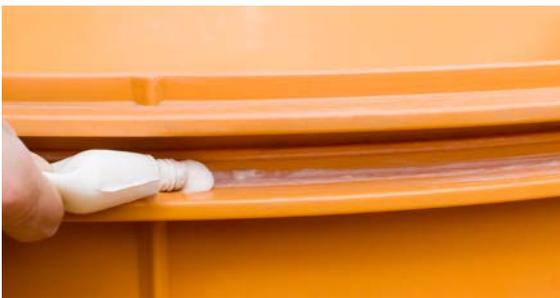
5 Zum Verbinden der Schachtelemente zunächst beide Flanken der obersten Dichtkammer mit Gleitmittel einstreichen. Damit wird das Aufspannen der Schachtelementendichtung erleichtert und der korrekte Sitz sichergestellt.
