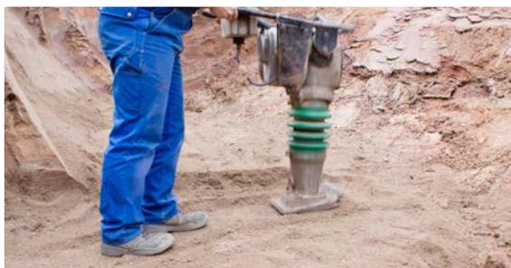
1 Der Auflagebereich des Schachtbodens ist gemäß DIN EN 1610 vorzubereiten. Dazu eine mind. 10 cm dicke, tragfähige Bettungsschicht (z. B. Sauberkeitsschicht) erstellen.
