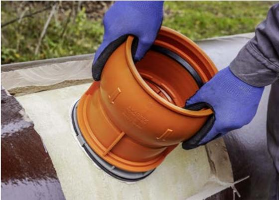
Der AWADOCK Polymer kann mit einer zusätzlichen quellfähigen Dichtpaste an mit Inlinern sanierten Rohren angeschlossen werden. Die quellfähige Dichtpaste dient vor allem dazu mögliche Unebenheiten oder ähnliches auf der Außenseite des Liners auszugleichen und somit für eine zuverlässige Dichtheit zu sorgen. Für den Anschluss muss jedoch ein Montagefenster in das sanierte Rohr geschnitten werden, so dass der Anschlussstutzen direkt auf den Liner angeschlossen werden kann.
