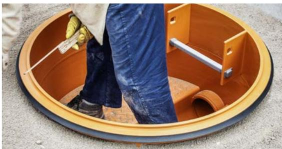
12 Schachtring und Abdeckplatte müssen sich 70 mm bis max. 90 mm überlappen, um die Dichtheit und korrekte Lastabtragung sicher zu stellen. Feinsplittschicht bzw. Betonfundament entsprechend herstellen. Siehe Einbauskitze auf Seite 174.
