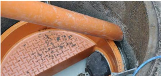
13 Schnell abbindenden, abwasserbeständigen Systemmörtel AWASeru nach Herstellervorgaben anmischen und mit Hilfe einer Rutsche in den Spalt zwischen Betonschacht und Sanierungsschachtboden gießen. Den Mörtel von einer Seite und ohne Unterbrechung einfüllen, bis die höchstgelegene Absperrblase mindestens 5 cm vom Mörtel umschlossen ist.
