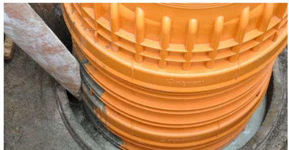
17 Den Spalt zwischen Betonschacht und Schachtring mit Vergussmörtel füllen. Bei größerem Verfüllvolumen können auch alternative fließfähige Verfüllmaterialien verwendet werden, um den Hohlraum zu verdämmen.
