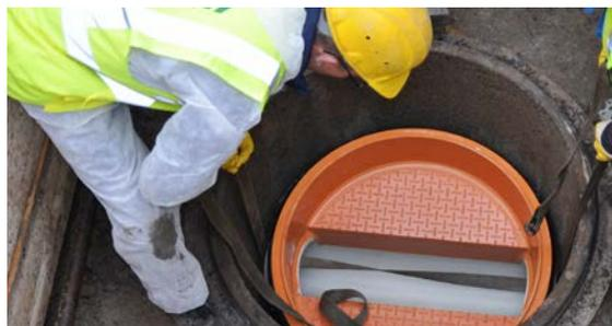
10 Den Sanierungsschachtboden endgültig in den Betonschacht herablassen und die Passung des Sanierungsschachtbodens mit den Anschlussrohren nochmals prüfen (Sohlhöhe und Winkel).
