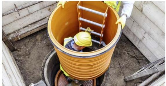
16 Um den Schachtring aufzusetzen, ist die Schachtelementdichtung gemäß Punkt 8 aufzuziehen. Die Muffe des aufzusetzenden Schachtrings säubern und gleichmäßig mit Gleitmittel einstreichen (Einbautipp: nicht die Dichtung mit Gleitmittel einstreichen.) Es ist darauf zu achten, dass die Muffe auch nach dem Einstreichen keine Verschmutzung aufweist. Schachtelemente ohne zu verkanten aufeinanderzusetzen und bis zum Anschlag zusammenstecken.
