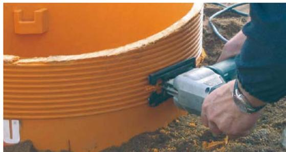
20 Der Schachtkonus wird ungekürzt auf die Baustelle geliefert und muss vor Ort an der Einstiegsöffnung gekürzt werden. Das Kürzmaß ist abhängig von der Einbautiefe des Schachtbauwerks und der Auswahl der Schachtabdeckung. Maximales Kürzmaß 25 cm. Gekürzt wird im Rippental, welche in einem Abstand von 1 cm angeordnet sind. Die Schnittfläche anschließend entgraten. Berechnung des Kürzmaßes siehe Einbauskitze auf Seite 184.
