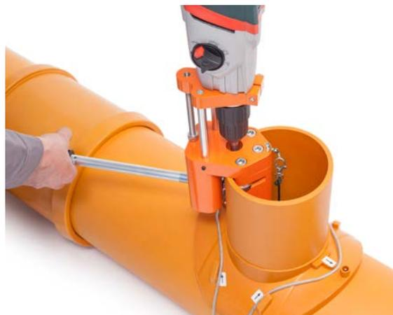
Die Verbindung der Anschlussleitung mit dem Sattel erfolgt mittels einer geeigneten Elektroschweißmuffe (Anschlussleitung AWADUKT PP SN10/HPP SN16) bzw. einer Doppelsteckmuffe (Anschlussleitungen aus glatten Kunststoffrohren DN/OD 160).
