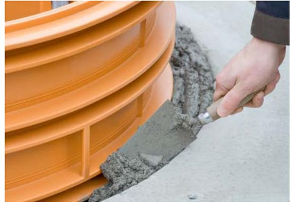
4.5 Spalt zwischen Stahlbeton-Lastverteilplatte und Schachtring DN 1000 mit Mörtel verfüllen.
