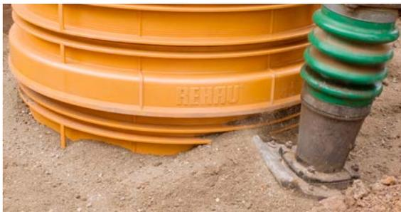
18 Zum Verfüllen der Schachtbauteile ist Boden der Gruppe G1 oder G2, max. Korngröße 63 mm (abgestufter Boden mit Feinanteilen) zu verwenden. Empfehlung: Verwendung von Recyclingmaterial. Verfüllmaterial in einer Breite von 40 cm (bei Einbau der Schächte in Grundwasser mind. 60 cm) sorgfältig und lagenweise in Schichtdicken von 20 bis 40 cm einbringen und gemäß den Vorgaben der DIN EN 1610, ATV-DVWK-A 139 verdichten. Verdichtungsgrad im Bereich von Verkehrsstraßen  $D_{Pr} \geq 97\%$ .
