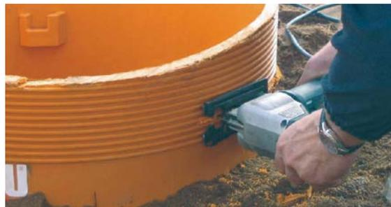
11 Der Schachtkonus wird ungekürzt auf die Baustelle geliefert und muss vor Ort an der Einstiegsöffnung gekürzt werden. Das Kürzmaß ist abhängig von der Einbautiefe des Schachtbauwerks und der Auswahl der Schachtabdeckung. Maximales Kürzmaß 25 cm. Gekürzt wird im Rippental, welche in einem Abstand von 1 cm angeordnet sind. Die Schnittfläche anschließend entgraten. Berechnung des Kürzmaßes siehe Einbauskizze auf Seite 171.
