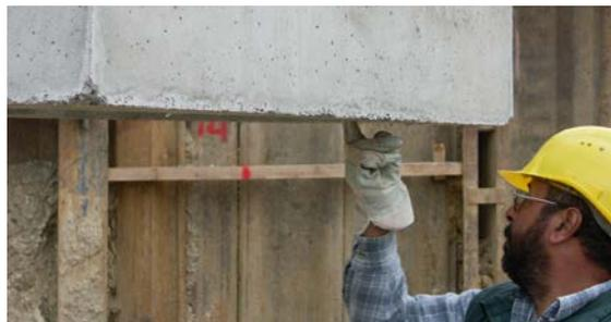
13 Schachtelementdichtung auf Beschädigungen und richtigen Sitz prüfen sowie von Verunreinigungen befreien. Betonabdeckplatte an der Dichtflanke mit Gleitmittel einstreichen.
