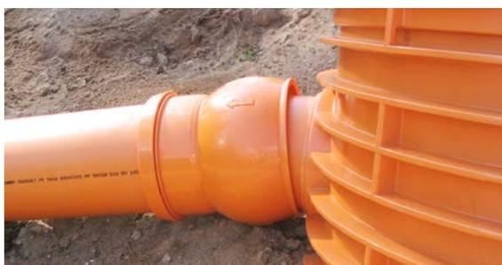
2a Mit den optionalen Kugelgelenken/Gelenkmuffen können Gefällewechsel bis zu 13% realisiert werden, alternativ bis zu 7,5° nach links/rechts. Bei gleichzeitigem Gefällewechsel und Richtungsänderung reduzieren sich die Werte entsprechend. Bei Kugelgelenken und Gelenkmuffen ist auf die Fließrichtung zu achten, die durch einen aufgeprägten Richtungspfeil gekennzeichnet ist.
