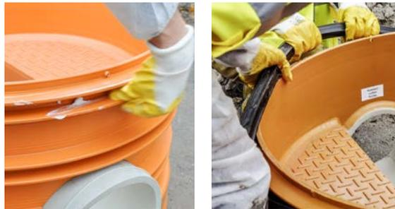
8 Nach dem Ausrichten des Schachtbodens die Schachtelementdichtung auf den Schachtboden montieren. Zum Aufspannen der Schachtelementdichtung zunächst die obere Dichtkammer mit Gleitmittel einstreichen. Anschließend die Elementdichtung mit der Schrift nach oben in die Dichtkammer einlegen und auf Beschädigung und richtigen Sitz prüfen, sowie von möglichen Verschmutzungen befreien.
