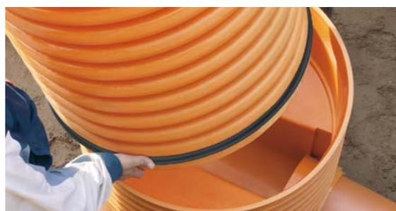
4 Zum Aufziehen der beigelegten Dichtung zunächst das unterste Wellental des Steigrohres von Verunreinigungen befreien und mit Gleitmittel einstreichen. Anschließend Dichtung aufspannen. Im nächsten Schritt den Steckbereich des Schachtbodens mit Gleitmittel einstreichen und das Steigrohr bis zum Anschlag einschieben.
