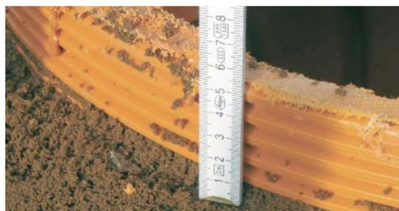
12 Die Verfüllung/Einbettung des Schachtbauwerks wird bis 5 - 6 cm unterhalb der Oberkante des gekürzten Konus (OKgK) hergestellt (siehe Einbauskizze auf Seite 171). Die Bettungsfläche muss plan ausgeführt werden und darf keine Punktlasten an den Hybridauflagering übertragen (ggf. Feinsplitt oder Mörtelschicht einbringen). Empfehlung: Abziehhilfe verwenden, um den Bettungsbereich für den Hybridauflagering eben und plan zu gestalten.
