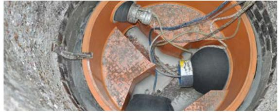
3 Die Absperrblasen dienen als Schalung für den schnell abbindenden Vergussmörtel, der zwischen Alt- und Sanierungsschachtboden gegossen wird um eine Anbindung des neuen Schachtgerinnes zu den vorhandenen Altrohren herzustellen.
