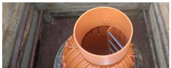
6 Wie bei einer Neuverlegung werden zuletzt nur noch der Konus, der Auflagering und die Abdeckung gesetzt.
