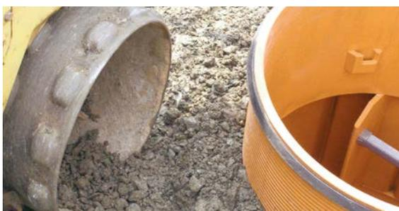
10 Analog zu Punkt 5 bis 8 weitere Schachtringe bzw. Schachtkonus aufsetzen und anschließend Verfüllmaterial gemäß Punkt 9 lagenweise einbringen und verdichten.
