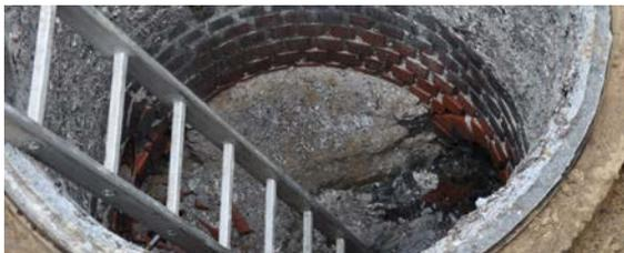
1 Im Vorfeld wird der Schacht aufgemessen. Anschließend muss der alte Betonschacht vorbereitet werden: Konus abtragen, altes Gerinne ausstemmen und Steigstufen/Steigeisen entfernen.
