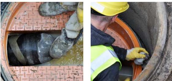
15 Die Winkeleisen und Absperrblasen entfernen und die Schachtelementdichtung reinigen, d. h. von Verschmutzungen und Mörtelresten befreien.
