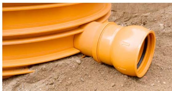
3 Gelenkmuffe/Kugelgelenk (ggf. im Lieferumfang des Schachtbodens enthalten) auf der Zulaufseite des Schachtbodens aufstecken. Bei richtungsgebundenen Muffen/Kugelgelenken den Anweisungen auf der Muffe folgen. Hinweise zum Steckvorgang beachten, siehe Punkt 2. Beim Aufstecken des Kugelgelenks DN 160/DN 200 ist auf die Fließrichtung zu achten, gekennzeichnet durch aufgeprägte Pfeile. Schachtboden ggf. seitlich mit Bettungsmaterial stabilisieren.
