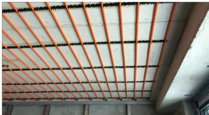
Fig. 6-26 Plafond chauffant / rafraîchissant, construction humide
