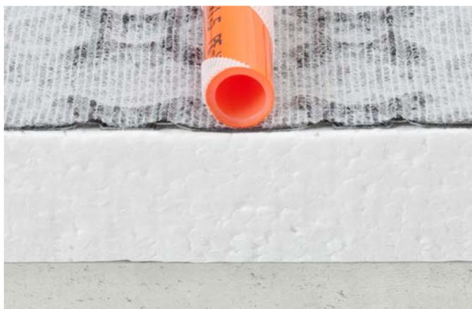
Fig. 4-47 Structure de sol avec isolation aux bruits d'impact supplémentaire
