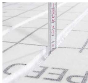
Fig. 4-138 Profondeur de rainure 20 mm entre le bord supérieur de l'isolation et le sommet de la rainure
