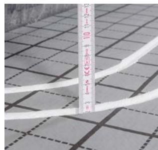
Fig. 4-146 Profondeur de rainure 20 mm entre le bord supérieur de l'isolation et la face supérieure de la rainure
