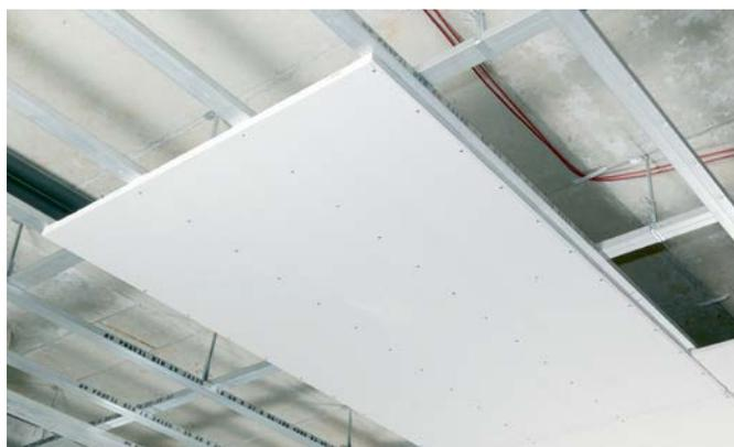
Fig. 6-11 Élément de plafond monté
