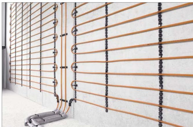
Fig. 5-17 Système de chauffage / refroidissement mural REHAU, construction humide
