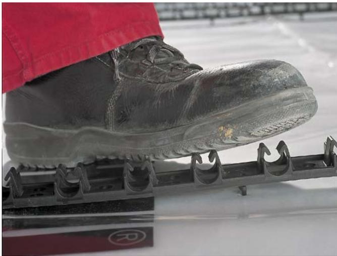
Fig. 4-129 Presser verticalement les rails RAUFIX sur leur support au sol
