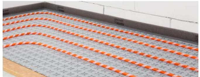
Fig. 4-42 Système à faible hauteur de pose RAUTHERM SPEED plus 2.0 sur plaque isolante en fibre de bois Knauf WF
