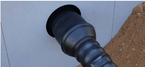
Afb. 05-16 Montagevoorbeeld huisaansluitset met krimpkous en schakelkettingdichting
