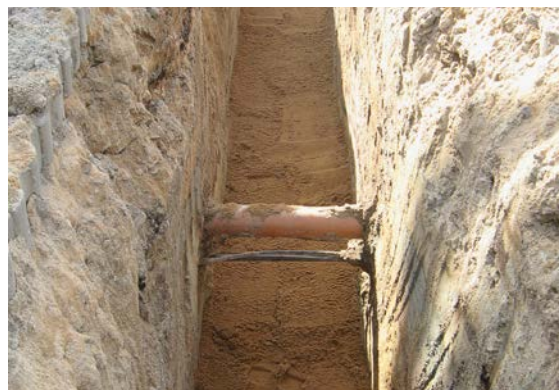
Afb. 07-2 Sleufbodem met buissteunvlak
