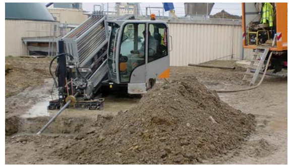
Afb. 07-10 Plaatsing met spoelboor
