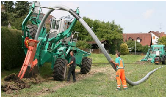
Afb. 07-8 Plaatsing met buisploeg
