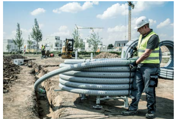
Afb. 07-34 Stationaire horizontale afrolhaspel aan het eind van de sleuf
