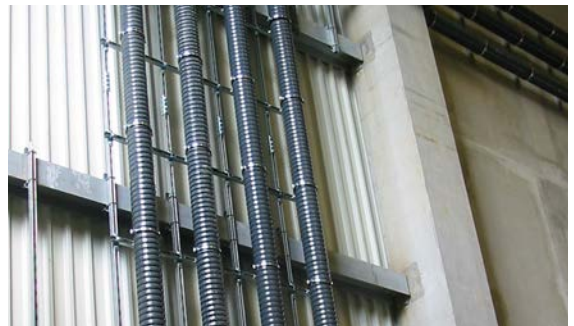
Afb. 07-29 Voorbeeld vrije plaatsing / wandmontage
