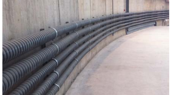
Afb. 07-28 Voorbeeld vrije plaatsing / wandmontage
