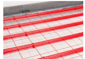
8 Nach bestandener Druckprobe (nach DIN EN 1264-4) ist das Rohrhaltesystem RAUTAC 10 bereit für die Aufnahme des Estrichs.
