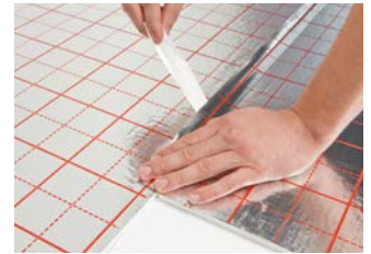
4 Die Schutzfolie an den Folienüberständen entfernen und die Plattenstöße miteinander verkleben. Plattenstöße ohne Folienüberstand mit REHAU Klebeband wasserdicht verkleben.
