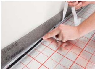
5 Den Randdämmstreifen mit der Gewebeoberfläche der Rohrhalteplatte verkleben.
