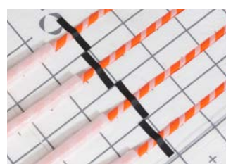
5 Bei Bedarf die Rohre in der Dämmebene zusätzlich mit dem RAUTHERM SPEED Fixierband befestigen.
