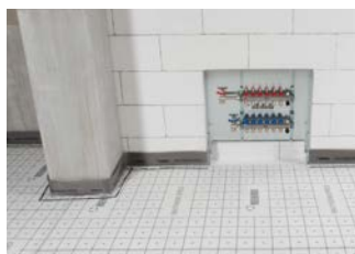
1 REHAU Randdämmstreifen und RAUTHERM SPEED Dämmplatte installieren. Anschließend den Folienfuß des Randdämmstreifens aufkleben.
