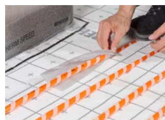
1 RAUTHERM iso Streifen unter das Heizrohr positionieren.
