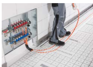
4 Vor- und Rücklauf des ersten Heizkreises sowie Heizkreis selbst installieren.
