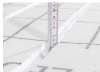
Hinweis: Die Tiefe der Nut ist 20 mm zw. Oberkante Dämmung und Scheitel Nut.
