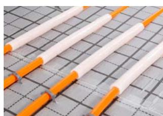
**3** Alle Rohre im Bereich des Ebenenwechsels mit dem RAUTHERM iso Streifen fest umwickeln.
