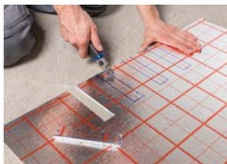
**2** Im Bereich der Türdurchführung die Rohrhalteplatte RAUTAC 10 ca. 15 cm lange und ca. 3 cm breite Rechtecke ausschneiden, sodass Reststege zwischen den „auftauchenden“ Rohren verbleiben.
