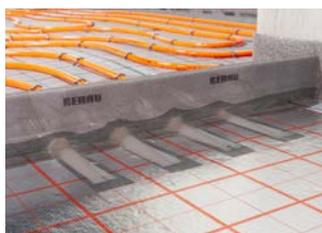
**5** Das Dehnfugenprofil mit Klebeband so abkleben, dass kein Estrichanmachwasser hindurch gelangen kann.
