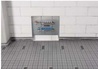
**1** REHAU Randdämmstreifen und REHAU Tackerplatte installieren. Den Folienfuß des Randdämmstreifens noch nicht verkleben, sondern nach oben hin mit Klebeband fixieren.
