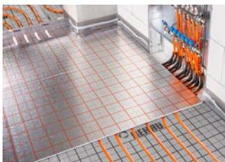
**1** Die Rohrhalteplatte RAUTAC 10 als Abdeckschicht auf der Dämmung mit den integrierten durchlaufenden Zuleitungen installieren.
