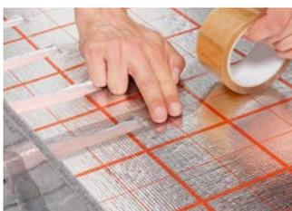
**4** Die Ausschnitte der Rohrhalteplatte RAUTAC 10 in Längsrichtung mit Klebeband so abkleben, dass kein Estrichanmachwasser hineingelangen kann.
