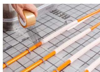
**4** Die Enden des RAUTHERM iso Streifens auf der Heizkreisseite abkleben, sodass kein Estrichanmachwasser hineingelangen kann.
