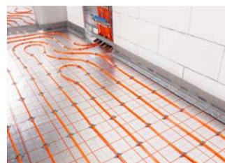
**7** Abschließend den Heizkreis nach Vorgabe des Systems Rohrhalteplatte RAUTAC 10 installieren.
