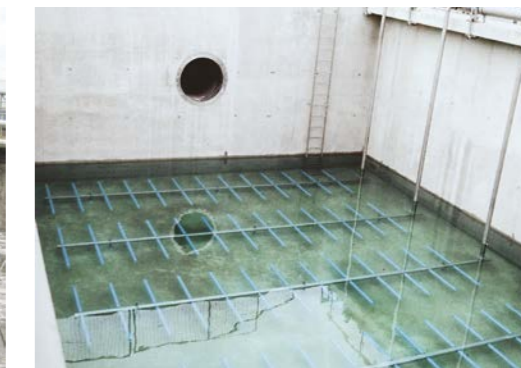
Kommunale Kläranlage Traunreut
