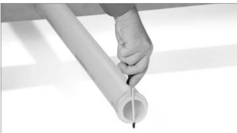
Bild 3: Montage mit Gegenhalter
