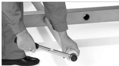
Rys. 4: Montaż przy użyciu klucza dynamometrycznego
