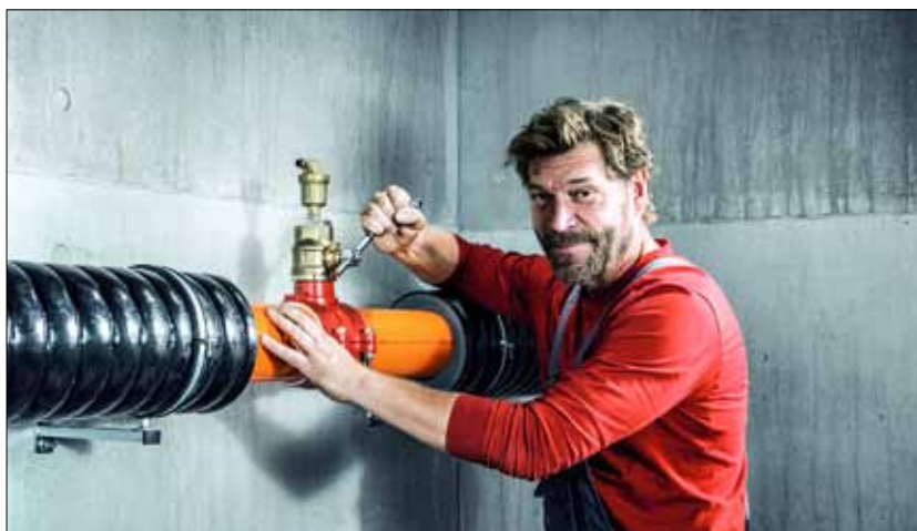
Bild 1. Anbohrvorgang mit der Armatur Nexus
