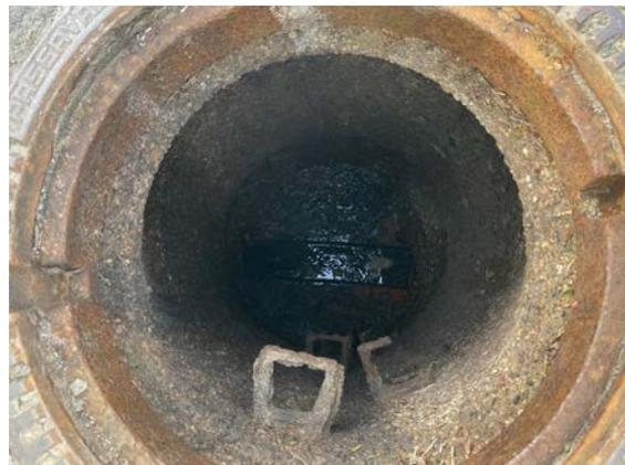
Durch biogene Schwefelsäure-Korrosion geschädigter Schacht
