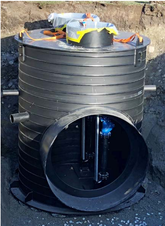
PE Schacht nach Versetzung
