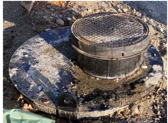
PE Schacht hinterfüllt mit aufgesetztem Gussdeckel B125
