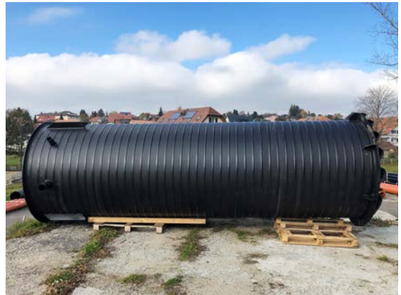
Liegende Lagerung PE Schacht auf Baustelle
