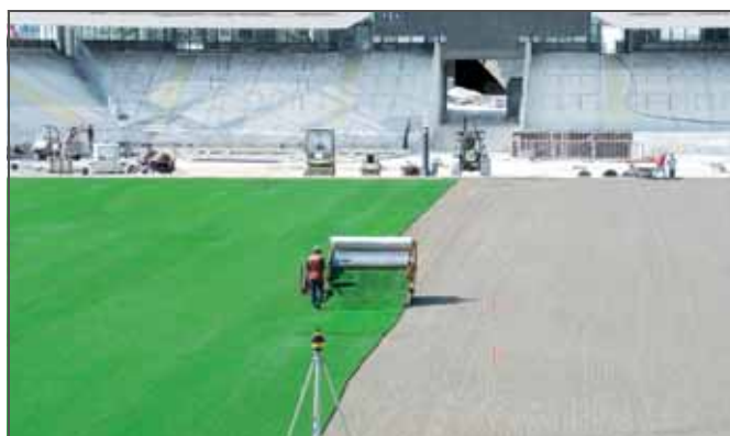
Rys. 4-35 Układanie trawnika z rolki
