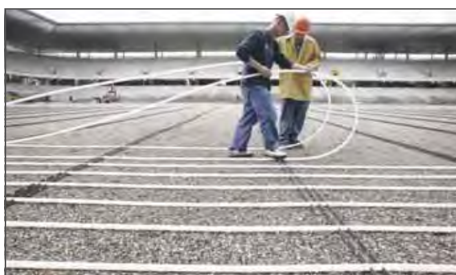
Rys. 4-34 Układanie rur grzewczych
