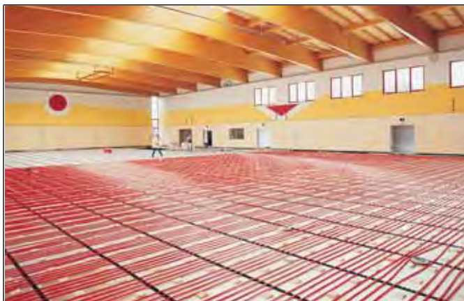
Rys. 4-17 System ogrzewania podłogi elastycznej z rozdzielaczem standardowym
