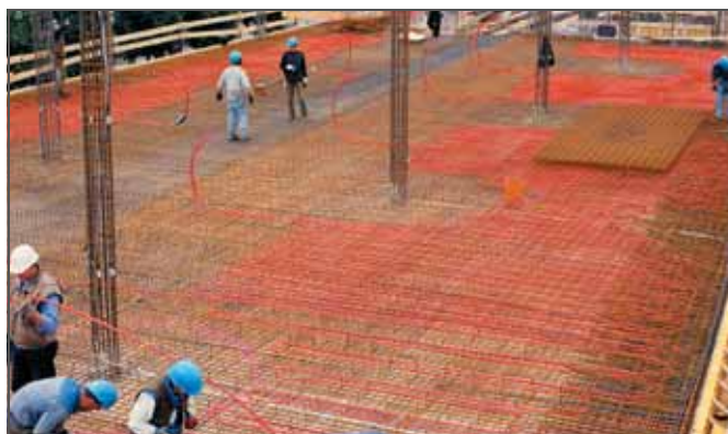
Rys. 3-4 System BKT REHAU układany na budowie
