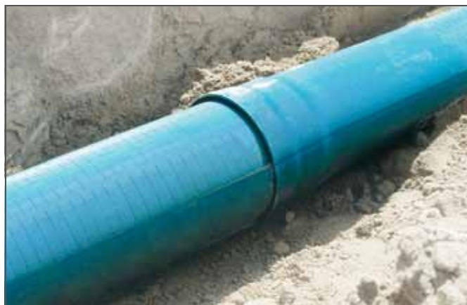
Rys. 4-33 Układanie systemu drenarskiego
