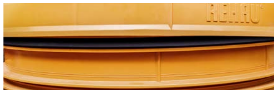
Fig. 05-30 Placer les éléments de regard les uns sur les autres
