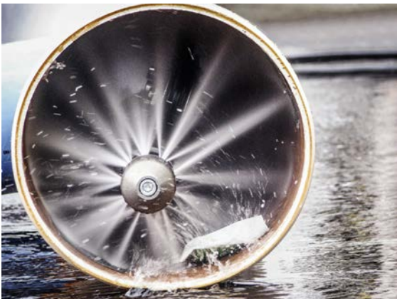
Fig. 06-2 Nettoyage à l'eau sous haute pression
