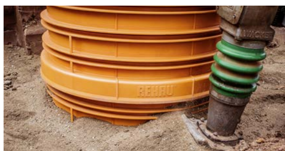
Fig. 05-31 Remplissage et compactage des alentours du regard
