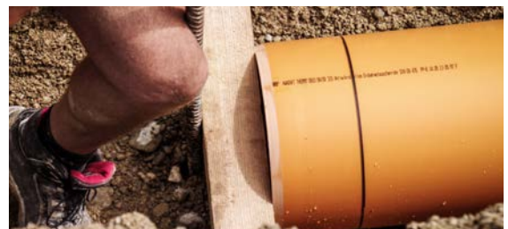
Fig. 05-14 Utilisation de leviers - Exemple pratique 2
