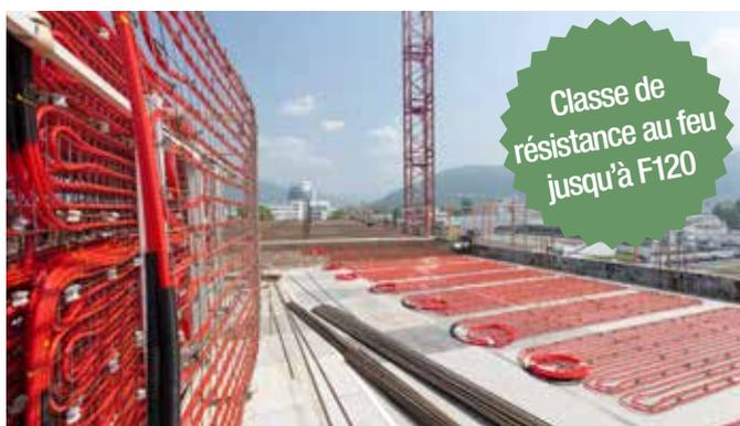
**Activation du noyau de béton et activation du noyau de béton en surface – Solution confortable et respectueuse de l'environnement pour l'équilibrage de la température des bâtiments**
