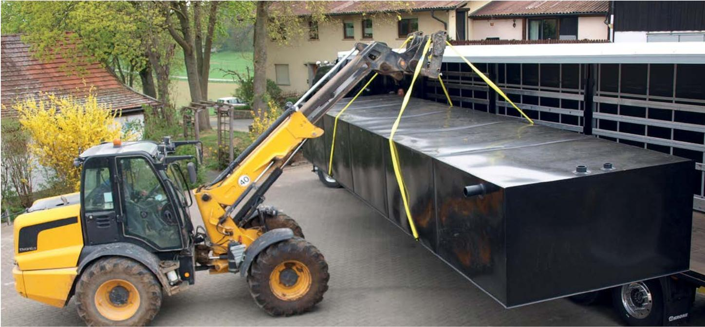
I modelli di accumulo, costituiti da celle RAUSIKKO racchiuse in piastre polimeriche, sono specificatamente impiegate per piccoli bacini.
