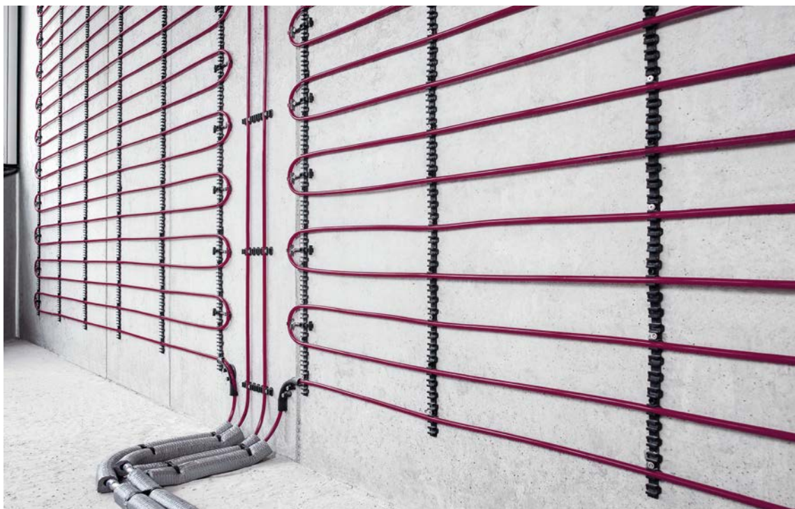
Sistema a parete costruito a umido che prevede l'utilizzo del binario di fissaggio REHAU 10 e del tubo RAUTHERM NEO-X5.
