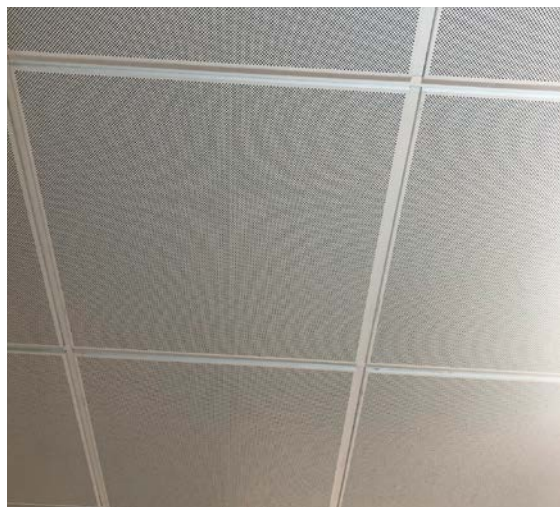
Riscaldamento/raffrescamento a soffitto ispezionabile e modulare
