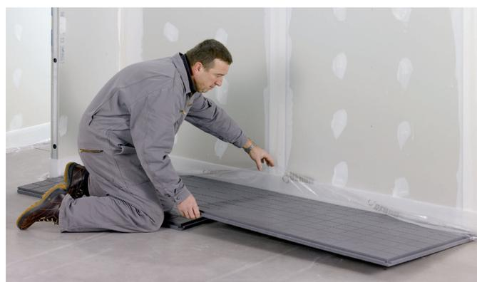
Fig. 2 Soulever la bavette + pose des dalles
