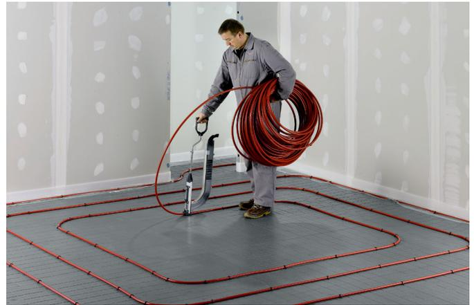
Fig. 3 Pose du tube
