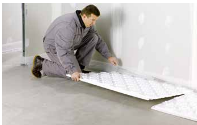
Fig. 2 Soulever la bavette + pose des dalles
