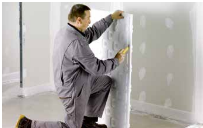
Fig. 1 Pose des plaques à plots en coupant les tenons mortaises
