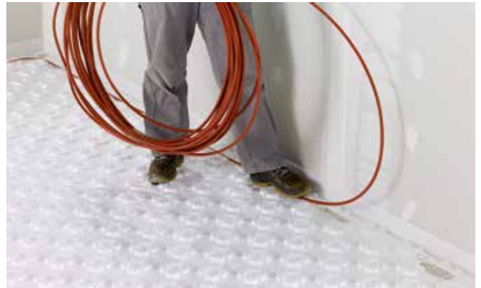
Fig. 3 Pose du tube
