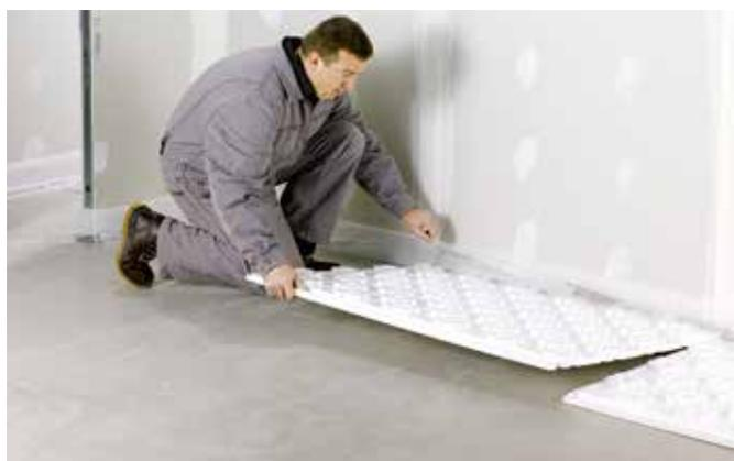
Fig. 2 Soulever la bavette + pose des dalles
