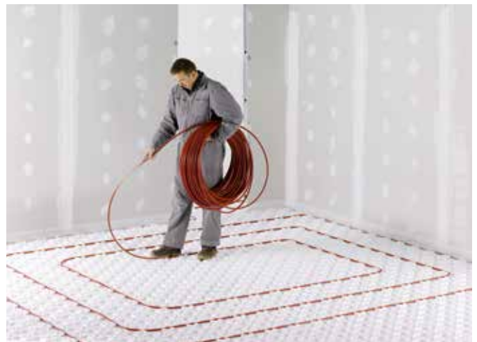
Fig. 3 Pose du tube
