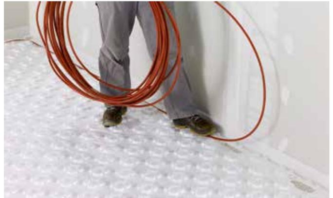
Fig. 3 Pose du tube
