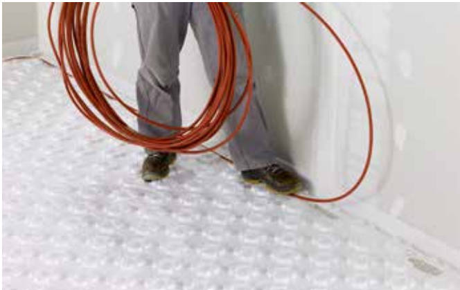
Fig. 3 Pose du tube
