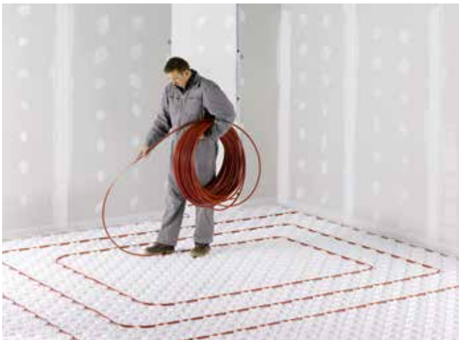
Fig. 3 Pose du tube
