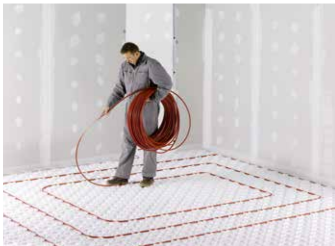
Fig. 3 Pose du tube
