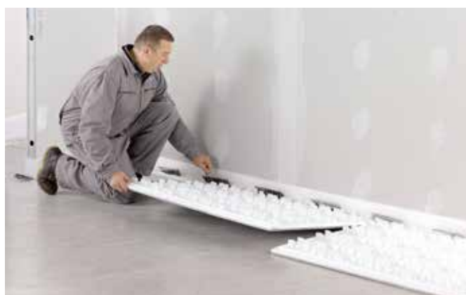
Fig. 2 Soulever la bavette et faire glisser la plaque
