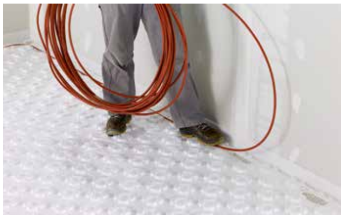
Fig. 3 Pose du tube
