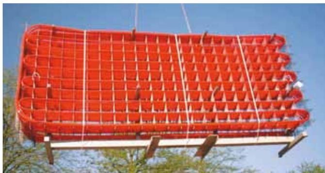
Ce mode de pose consiste à livrer et poser sur chantier des modules préfabriqués où le tube est déjà fixé sur des treillis standards ou spécifiques. A l'issue du dimensionnement spécifique du projet, les modules chauffants sont réalisés et repérés par des étiquettes d'identification pour garantir l'ordre de la pose des éléments sur le chantier.
