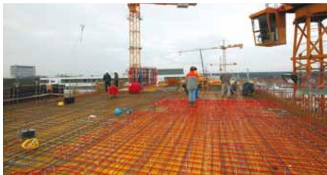
Le mode de pose "in situ" consiste à poser le tube et à le ligaturer directement sur le ferrailage existant de la dalle. Cette mise en œuvre est généralement effectuée sur des surfaces moins importantes que celles couvertes à l'aide des modules préfabriqués.
