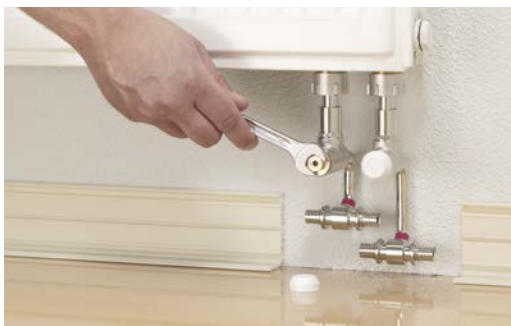
Сл. 18-12 Цврсто се стегнуваат засечените компресиони навртки
