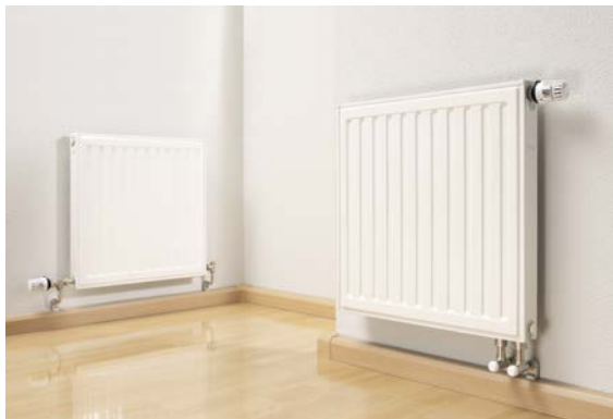
Сл. 18-1 Приклучување на грејно тело од подна лајсна
