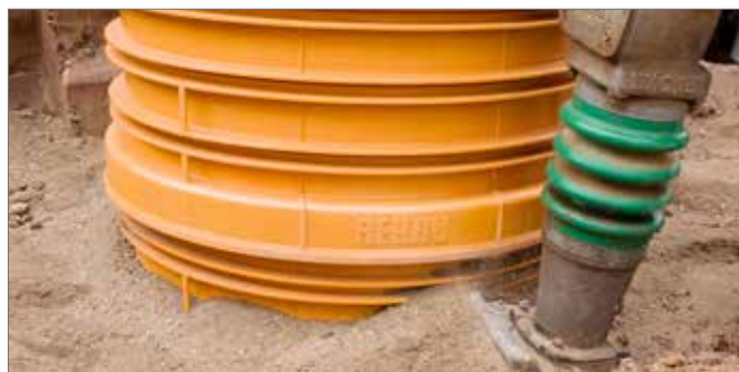
Afb. 5-31 Vullen en verdichten van de schachtomgeving
