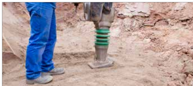
Afb. 5-25 Ondergrond van de schachtbodem voorbereiden
