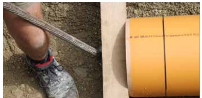
Afb. 5-14 Toepassing van hefboom – praktijkvoorbeeld 1
