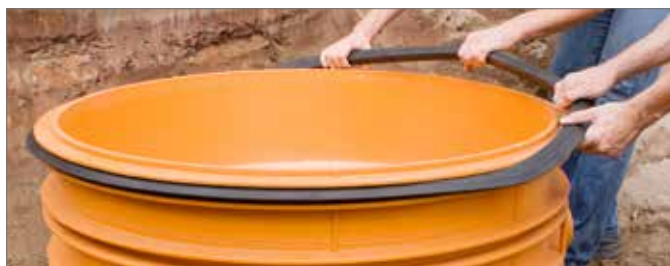
Afb. 5-27 Opspannen van de schachtelementafdichting
