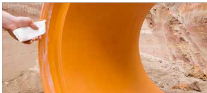
Afb. 5-29 Mof van de schachtring gelijkmatig met glijmiddel insmeren
