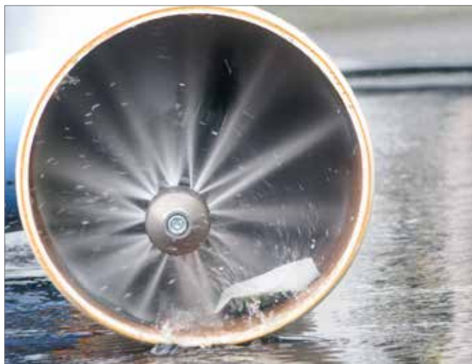
Afb. 6-2 Reiniging met hogedrukwater
