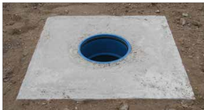
Afb. 5-2 Betonnen sokkel met dubbele insteekmof
