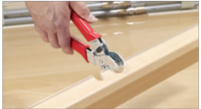
Afb. 17-46 Aanbrengen van uitsparingen in plintgoot
