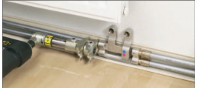
Afb. 17-33 Schuifhulsverbinding afmeting 16 op SL-kruising T-stukset RAUTITAN 16 - 12 - 16
