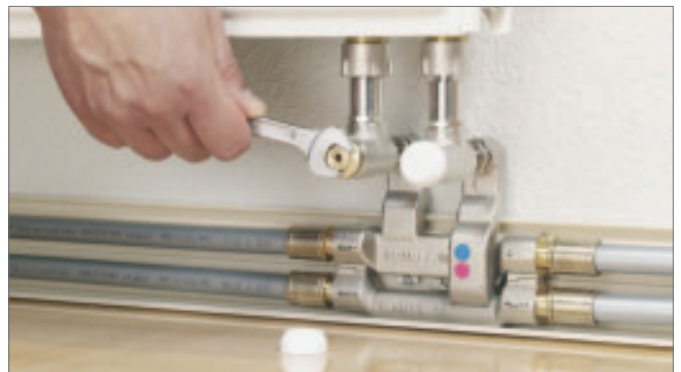
Afb. 17-38 Draai de klemringkoppeling vast
