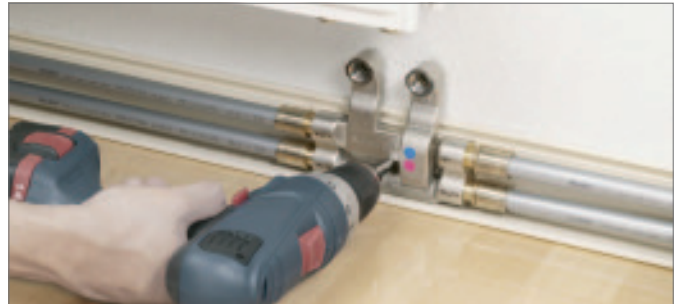
Afb. 17-35 SL-kruising T-stuk RAUTITAN bevestigen
