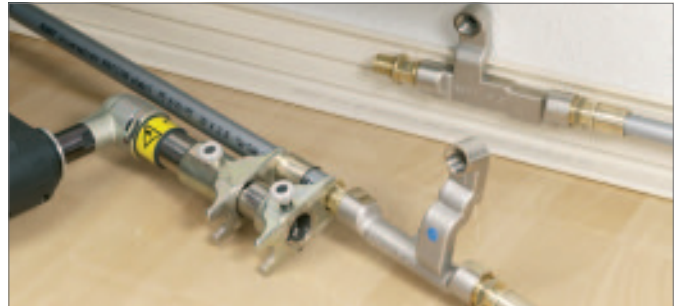
Afb. 17-34 Schuifhulsverbinding afmeting 20 op SL-kruising T-stuk RAUTITAN
