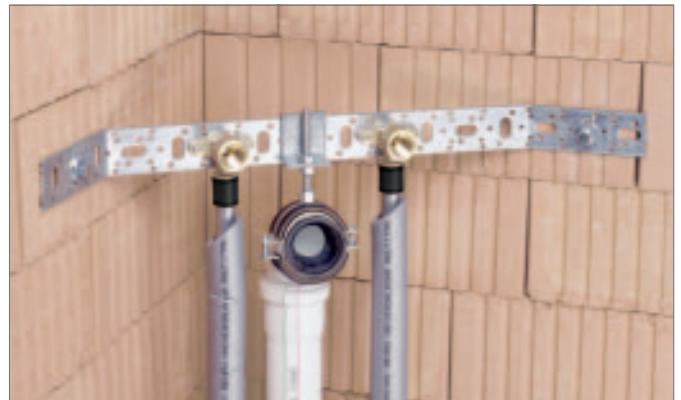
Afb. 5-3 Inbouwvoorbeeld montagerail
