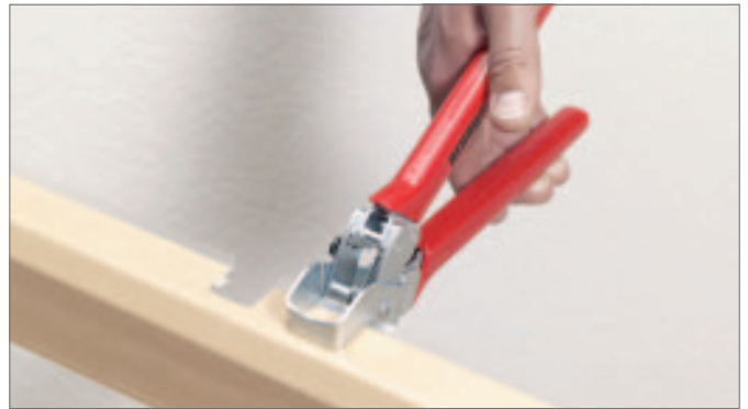
Afb. 17-39 Aanbrengen van uitsparingen in plintgoot
