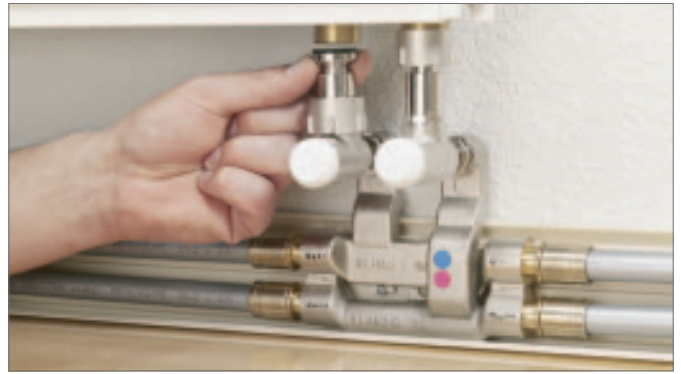
Afb. 17-37 Aansluiten van telescoop-hoekkoppelsset op ventielradiator
