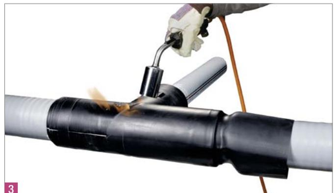
**4** Schieben Sie den Schrumpfschlauch 5 cm über die Schaumeinfüllöffnung und schrumpfen Sie diese ab.
