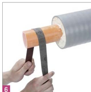
**6** Entfernen Sie die Schaumreste vom Mediumrohr mit Schleifpapier.
