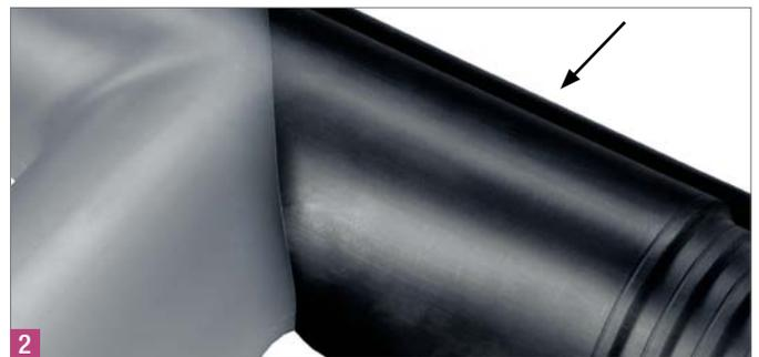
**3** Tragen Sie an den Schrägen nur so viel Wärme ein, dass der Kleber aufschmelzen kann. Pressen Sie die Schrumpfschläuche bei Bedarf mit einem Lappen an.
