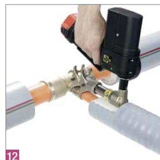
**12** Bei der Herstellung eines T-Abzweiges verpressen Sie das dritte Rohr. Falls erforderlich schneiden Sie einen Keil als Freiraum für das Verpresswerkzeug aus. Sind diese Schritte durchgeführt ist die Rohrverbindung beendet.
