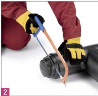
**2** Sägen Sie die Muffenenden entsprechend der anzuschließenden RAUTHERMEX Mantelrohrabmessungen ab (siehe Markierungen an den Stufen).
