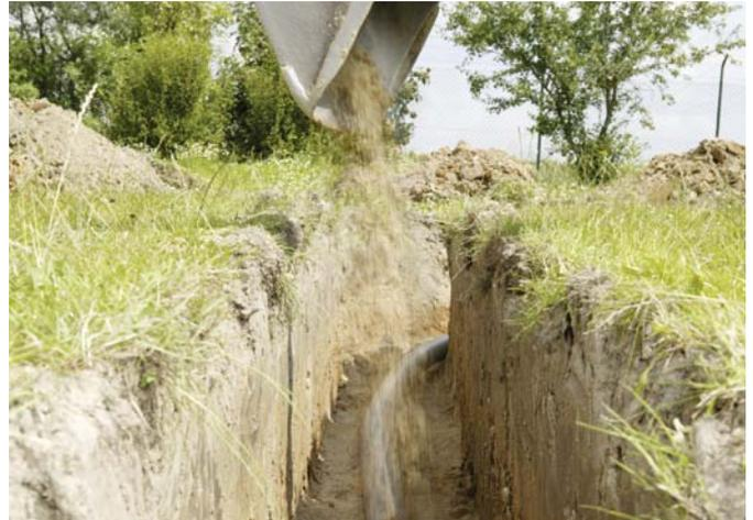
Abb. 56 Rohrgraben mit Sand füllen
