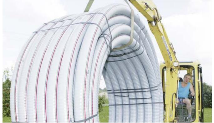
Abb. 47 Aufnehmen mit dem Bagger
