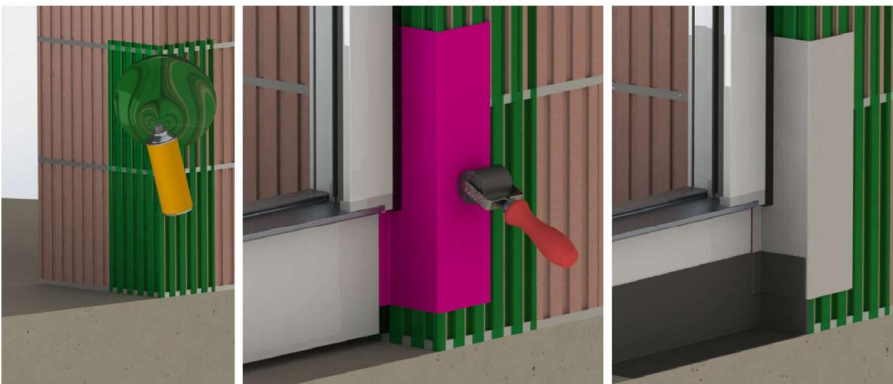
Um eine dauerhafte Verklebung zum Baukörper sicherzustellen, ist eine Vorbehandlung mit REHAU Sprühprimer 1367980 oder Streichprimer 1367981 erforderlich. Das Aufbringen des Anschlussflansches soll spannungsfrei und ohne Falten auf dem Baugrunderkörper erfolgen (nicht auf dem WDVS!). Nach dem Entfernen der Schutzfolie ist zügig zu verkleben. Zum Anrollen des Anschlussflansches kann eine handelsübliche Andrückrolle verwendet werden.
